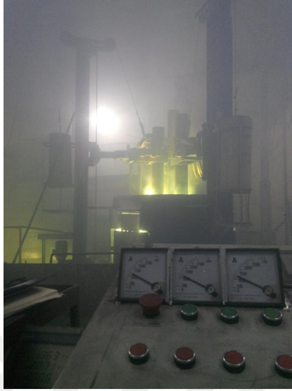
Şekil 3.5. Elektrik Ark Fırını
