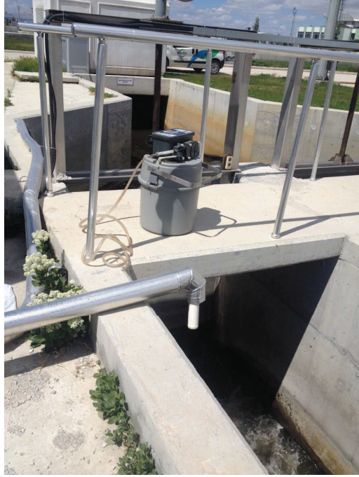
Resim 3.3 Konya Atıksu Kanalı Çıkışı Numune Alma Noktası
