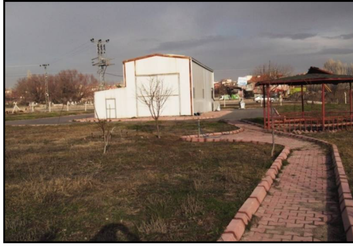
Resim 2.39. Buğdaylı Atıksu Arıtma Tesisi [58]
