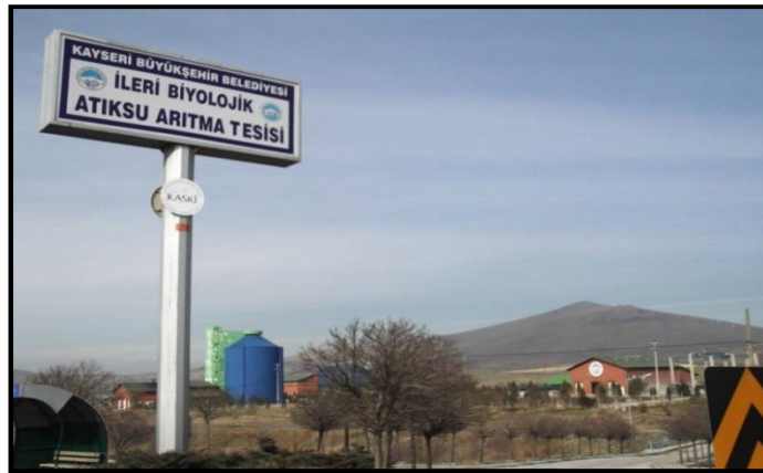
Resim 2.16. Kayseri İleri Biyolojik Atıksu Arıtma Tesisi [58]
