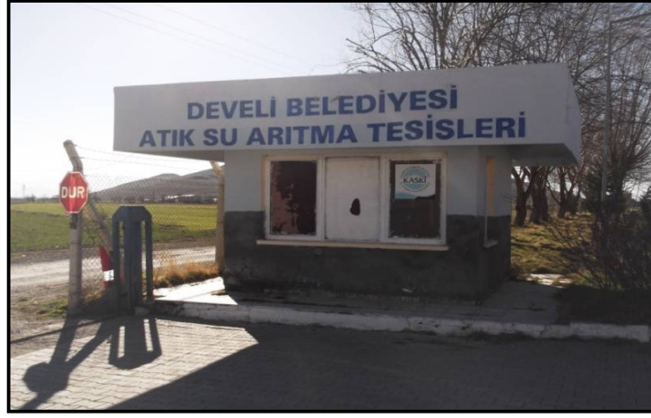
Resim 2.45. Develi Atıksu Arıtma Tesisi [58]
