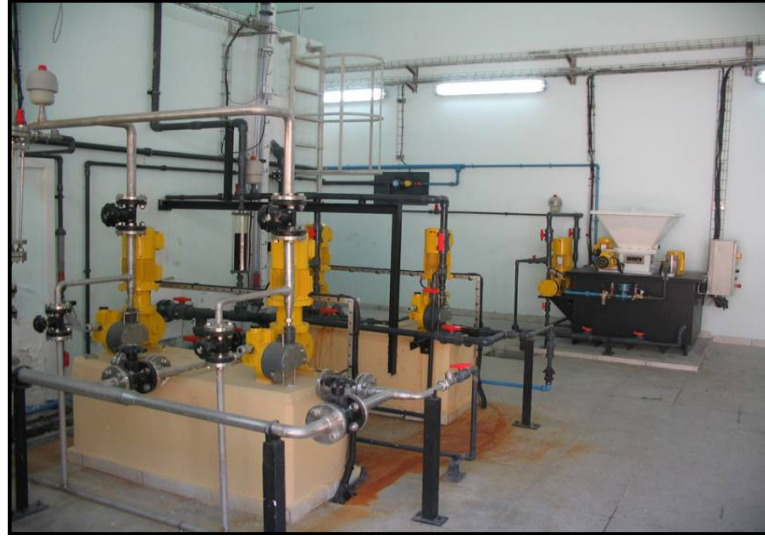
Resim 2.7. Koagülasyon için hızlı karıştırıcı [47]
