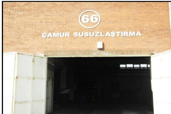
Resim 2.30. Çamur susuzlaştırma binası [58]
