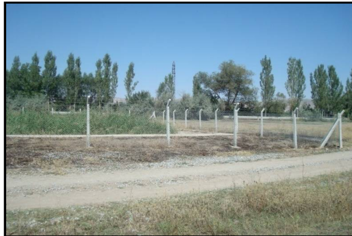
Resim 2.53. Salur Atıksu Arıtma Tesisi [58]
