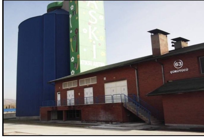
Resim 2.29. Çamur çürütme binası [58]
