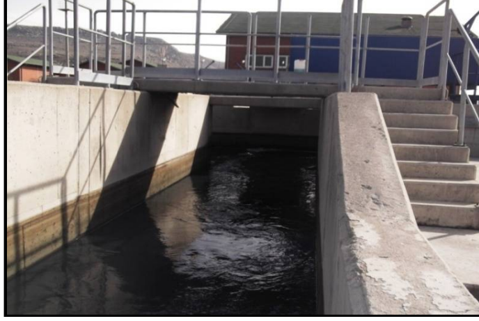
Resim 2.21. Giriş debi ölçüm kanalı [58].
