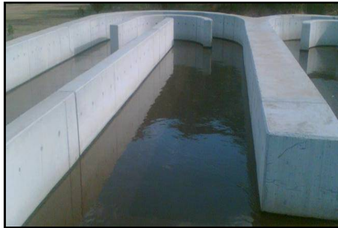
Resim 2.11. Anaerobik havuz örneği [3]
