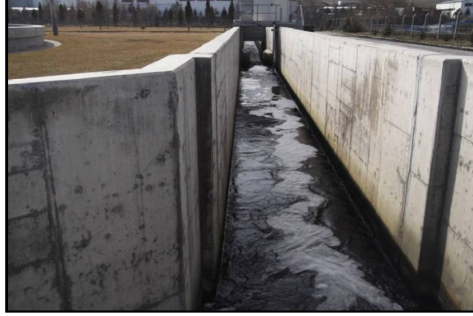
Resim 2.27. Çıkış debi ölçüm kanalı [58]
