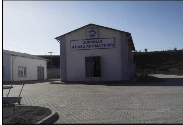
Resim 2.31. Gürpınar Atıksu Arıtma Tesisi görünümü [58]
