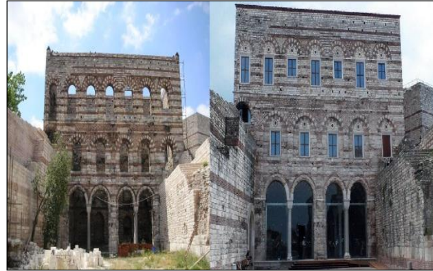
Şekil 9: Tekfur Sarayı ve restorasyonu [6]
