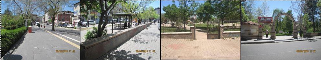
Şekil 4: Araştırma alanında sınırlama elemanları ve giriş kapılarından görünüm
