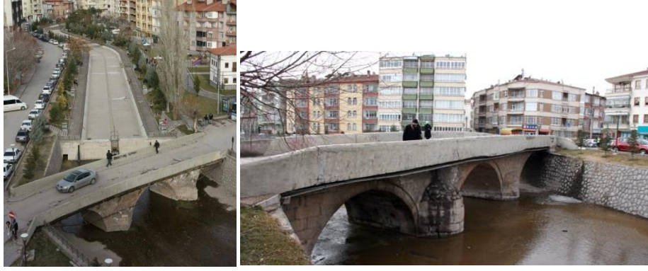
Resim 10. ve 11. Debağlar Köprüsü restorasyon öncesi görünümü
