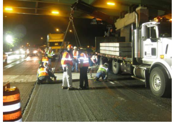
Şekil 1: Aralıklı onarımın şematik açıklaması ve fotoğrafı
