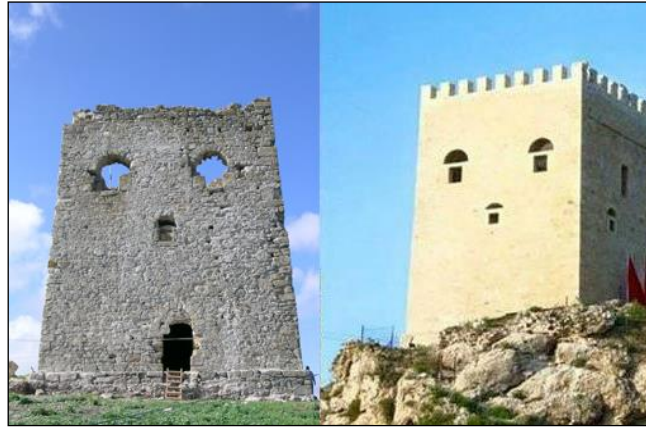
Şekil 2: Ocaklı Ada Kalesi ve restorasyonu [6]
