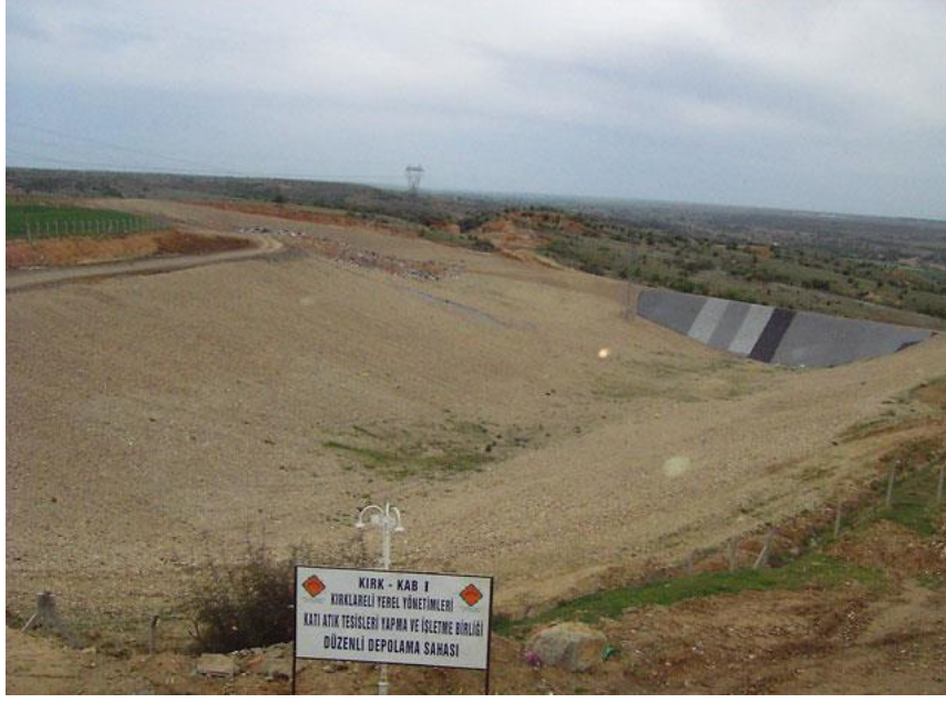
Şekil 1 : Düzenli Depolama Tesisi
