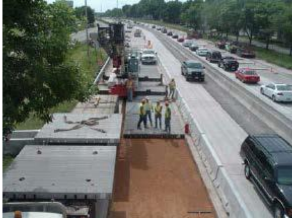
Şekil 4: Derzli prefabrik beton kaplama uygulamasının bir örneği
