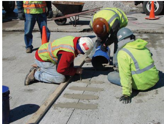
Şekil 2: Dübel çubuğu güçlendirme yöntemi kullanılarak panel montajından sonra yerleştirilen dübel çubuklarıyla gerçekleştirilen aralıklı tamir tekniğinin bir başka varyasyonu
