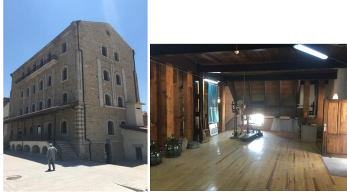
Resim 23. ve 24. Azmi Milli Un Fabrikası restorasyonu ve yeniden işlevlendirme sonrası günümüz görünümü
