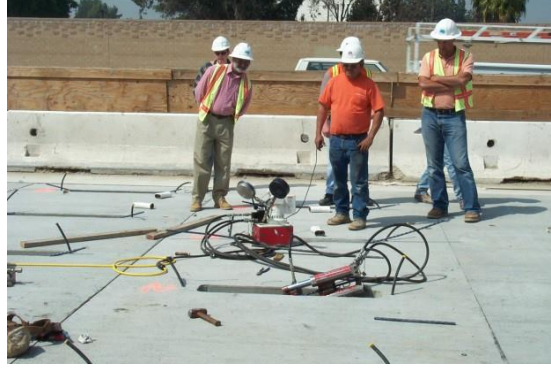
a) Orta panelde germe cepleri olan prefabrik ön gerilmeli beton kaplama sistemi
