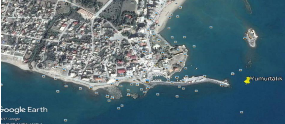
Şekil 5: Adana-Yumurtalık Balıkçı Barınağı
