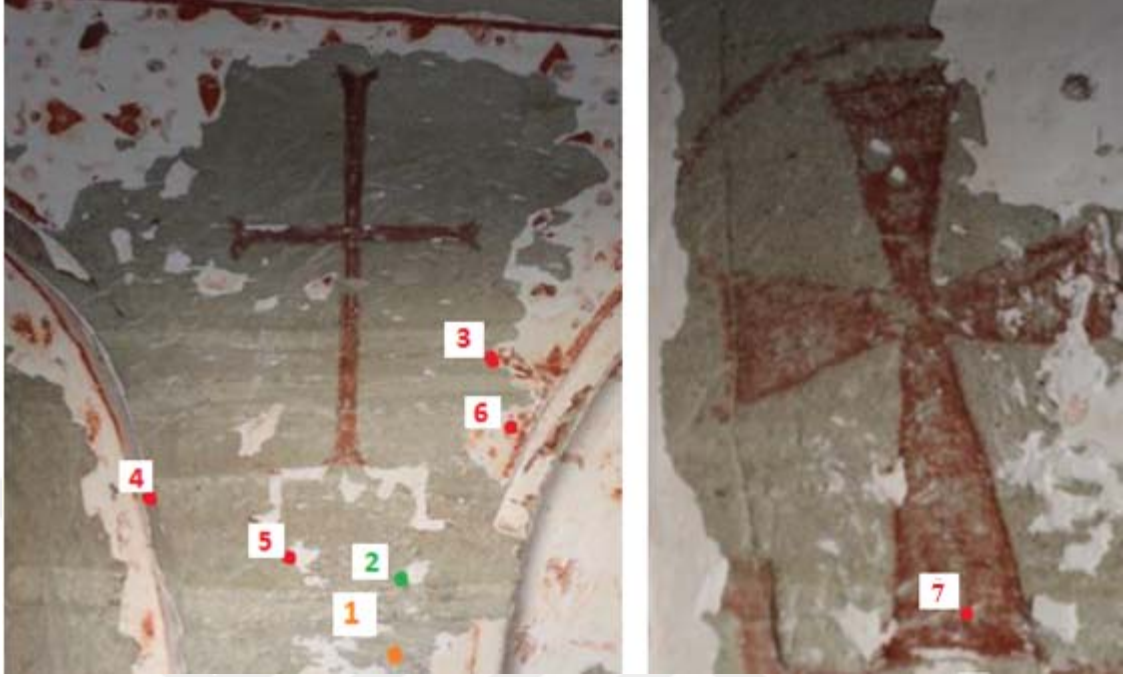
Şekil 3. 3. Aşk Kilisesi'nin giriş karşı ve sağ duvarından alınan örnekler
