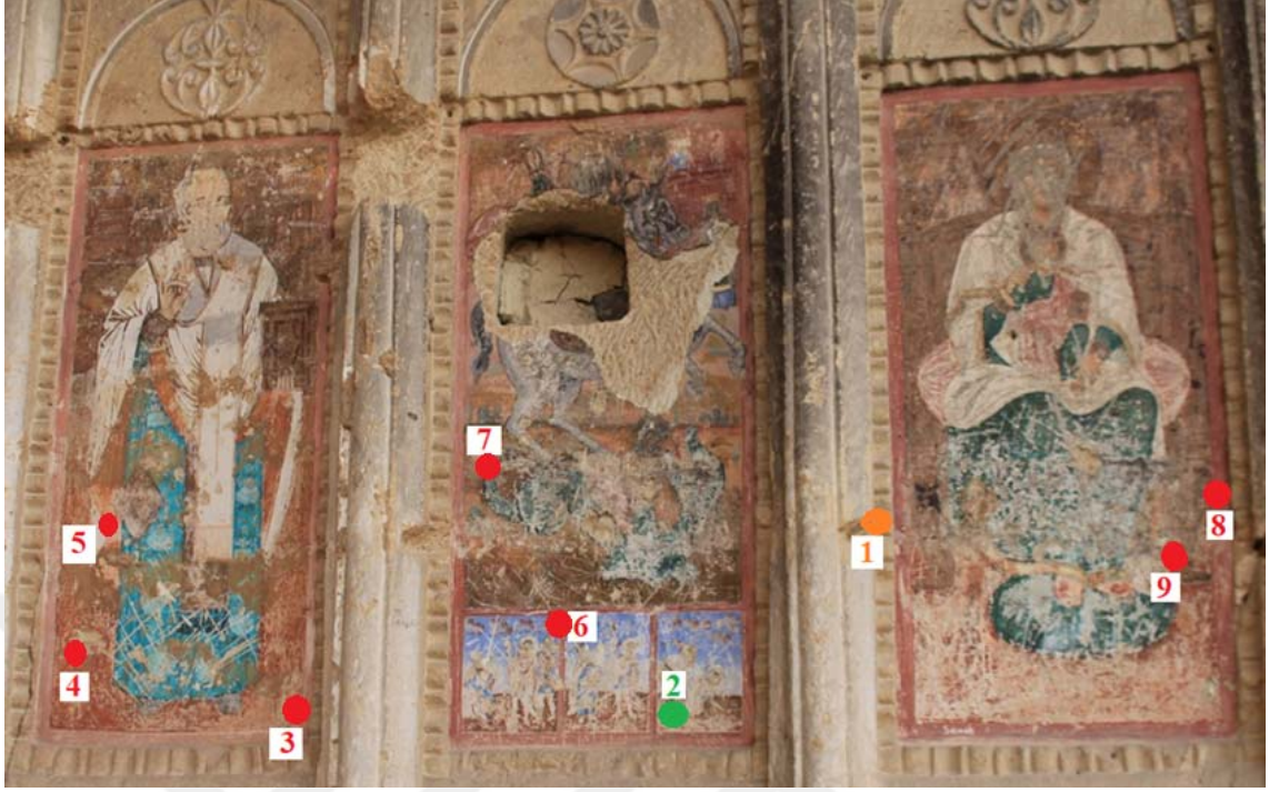
Şekil 3. 15. Hıdırellez Kilisesi iç duvarlarından alınan örnekler
