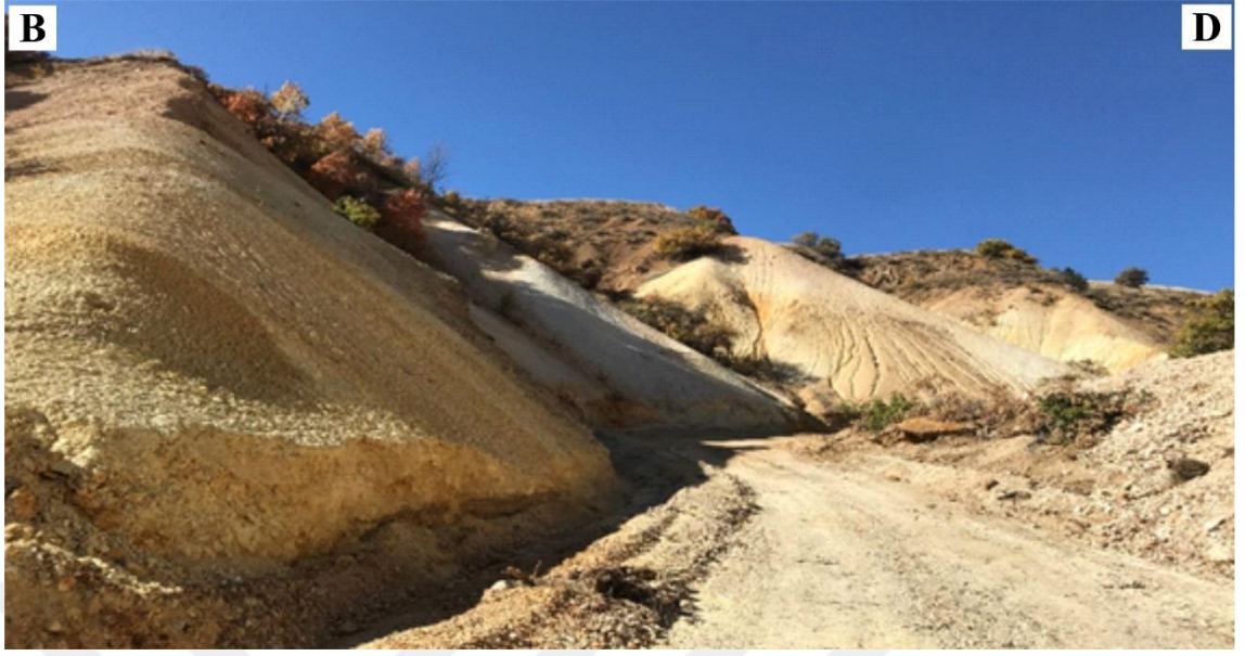
Şekil 3.12 Çilliğın Vadisi içerisinde kaolenleşme zonunun arazi görüntüsü.
