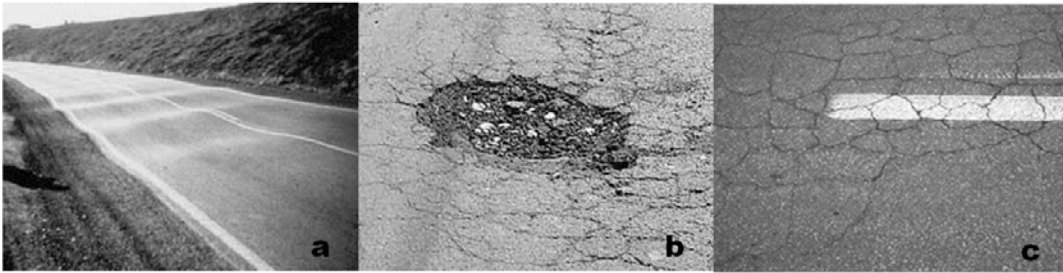
Şekil 1. a: Ondülasyon, b: Ayrışma nedeniyle oluşan yüksek şiddette bir çukur, c: Timsah sırtı çatlak
