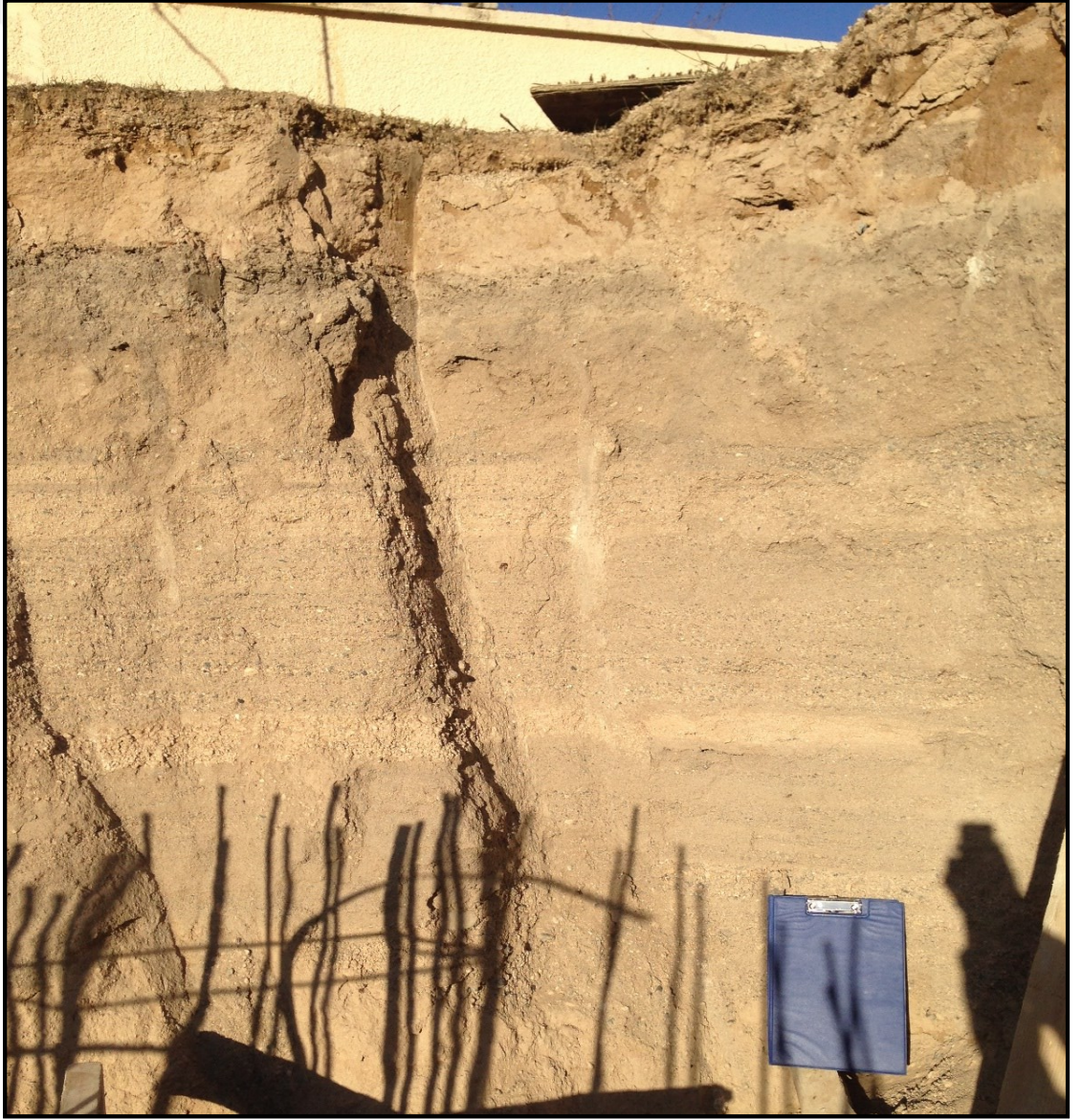
Resim 4.4. Çalışma alanı içerisindeki temel kazısında gözlenen Alüvyon birim
