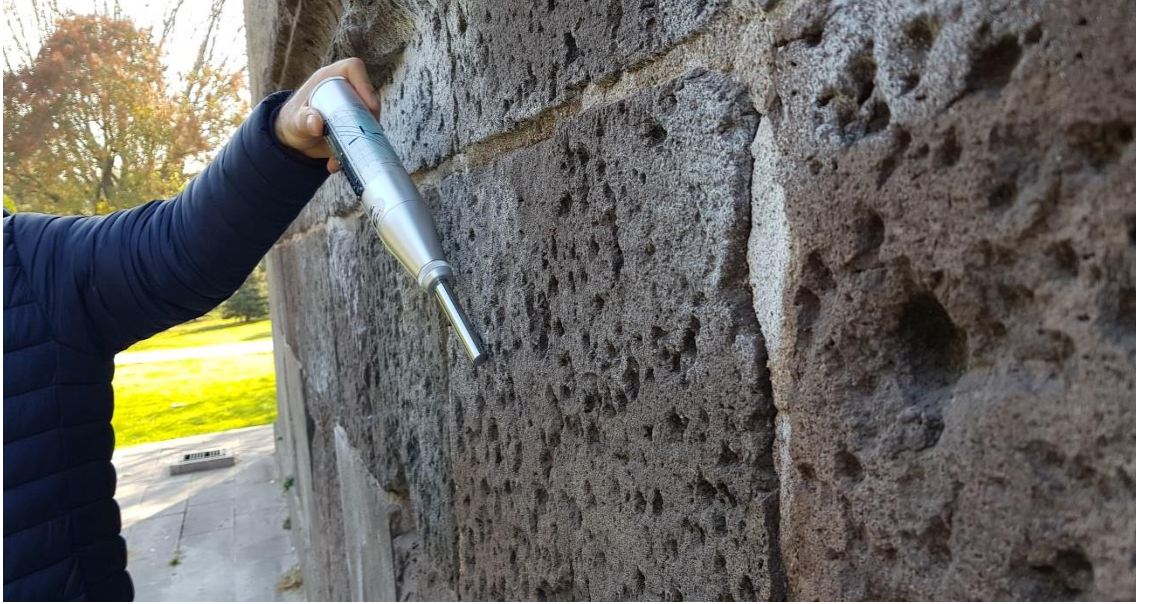
Şekil 6. 35 Emir Ali Pişrev Kümbeti'ndeki bloklarda oluşan tuzlanmalar ve oyuklanmalar
