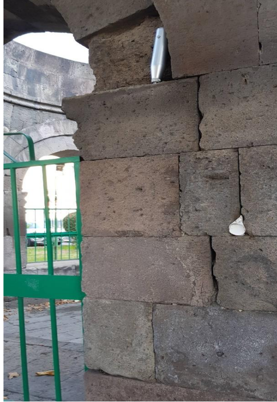
Şekil 6. 34 Suya Kanmış Hatun Kümbeti’nde belirlenen derz boşalmaları ve bloklar arasında boşluk oluşumu ayrılmalar
