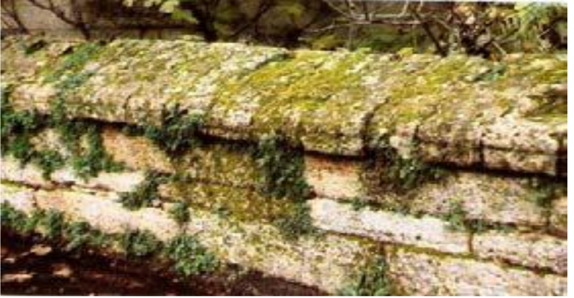
Şekil 5. 20 Edirne Beyazıt Camii kalkerli bahçe duvarı üzerinde nem oranının yükseldiđi kış aylarında ortaya çıkan, yazın uykuda kalan liken ve karayosunlarının oluşturduđu bozunma [29]
