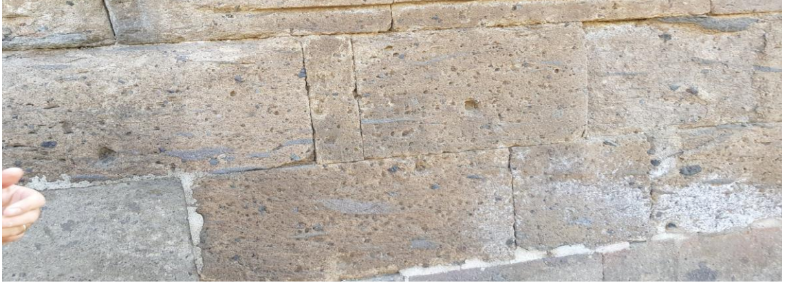
Şekil 6. 20 İgnimbiritlerde yassı pomza içeren bloklarda tuzlanma ve petegözlülük ve boşlukların sonradan çimento ile doldurulması
