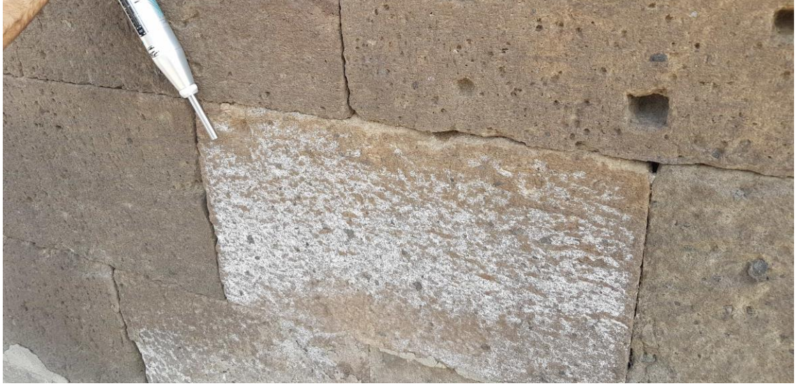
Şekil 6. 13 Köşk Medresesi'ndeki ignimbirit bloklarında tuzlanma etkileri
