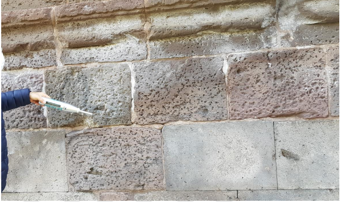
Şekil 5. 5 Emir Ali Pişrev Kümbeti'nde gözlenen tuzlanma ve petekgözlülük
