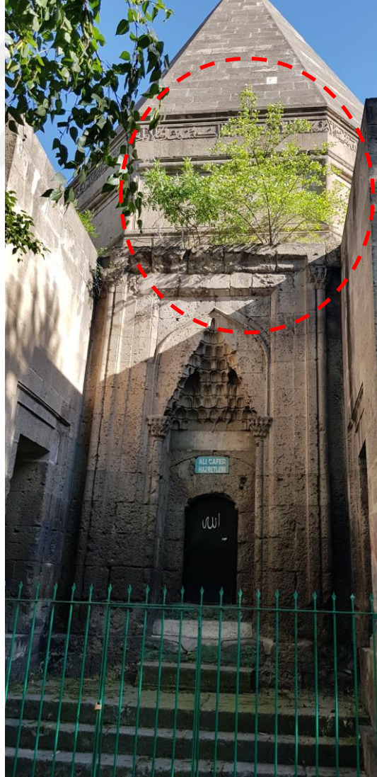
Şekil 6. 23 Ali Cafer Kümbeti üzerinde büyüyen ağaç gövdesi
