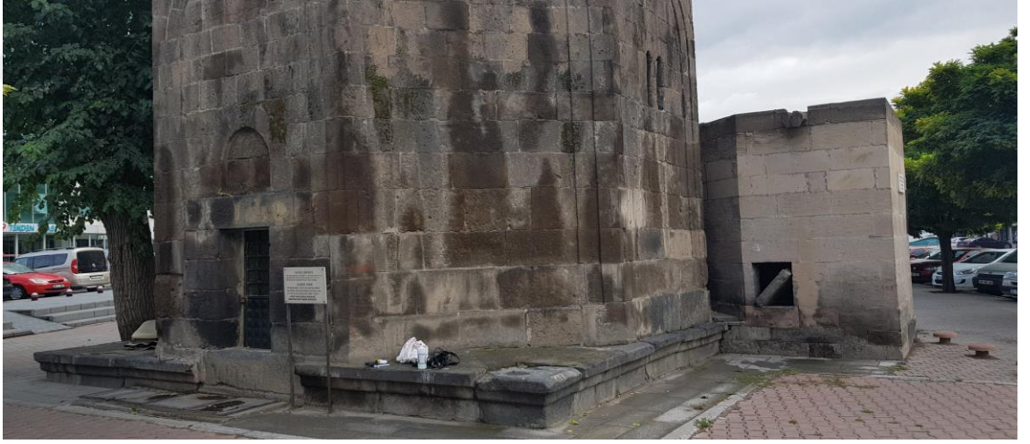
Şekil 6. 8 Hasbek Kumbeti'nde kahverengi ignimbirit malzemesinde meydana gelen kararmalar
