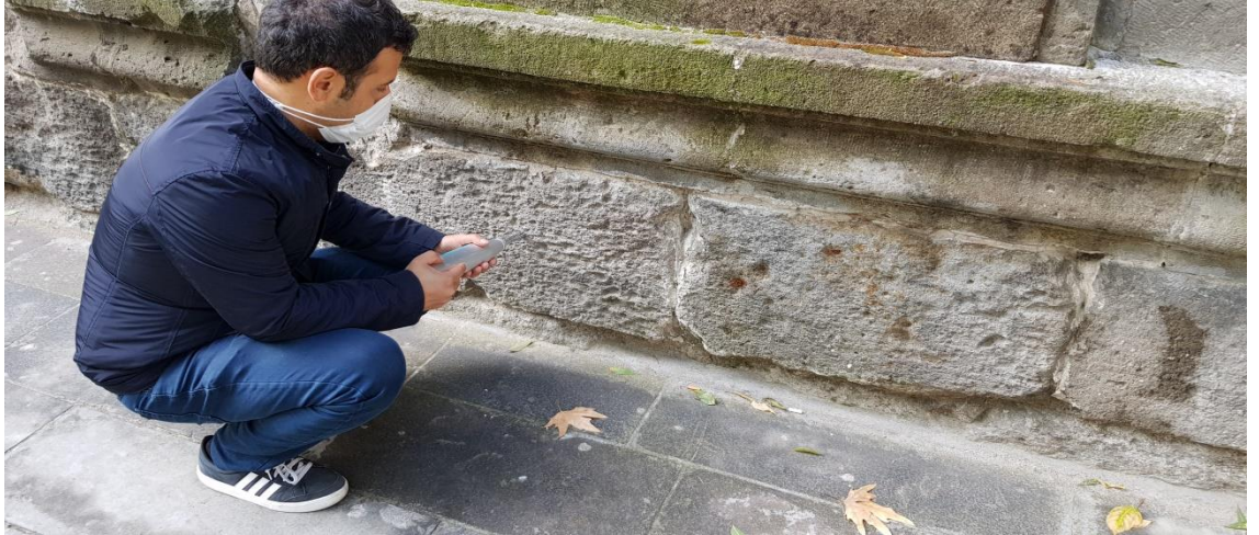
Şekil 6.31 Emir Ali Şahap Kumbeti’nde gözlenen yosunlanma ve petegözlülük
