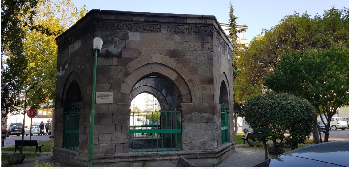
Şekil 6. 33 Suya Kanmış Hatun Kümbeti’nde gözlenen kararmalar ve tuzlanmalar
