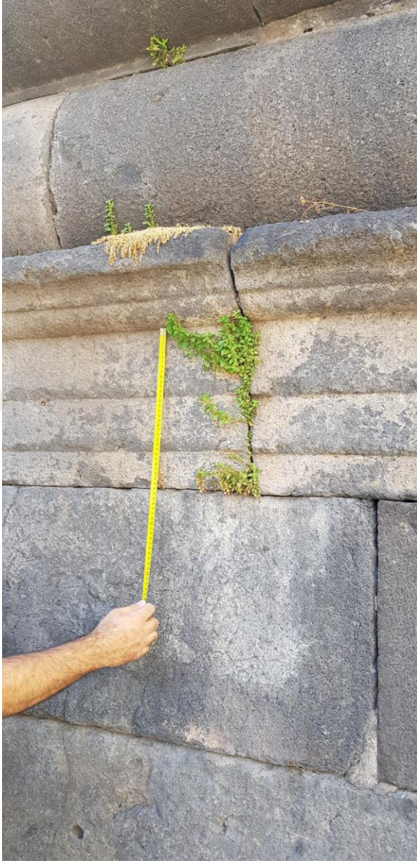
Şekil 6. 3 Derz aralarına yerleşen bitki tohumlarının büyümesi
