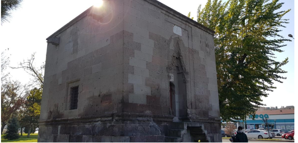
Şekil 2. 17 Emir Ali Türbesi’nin genel dış görünümü
