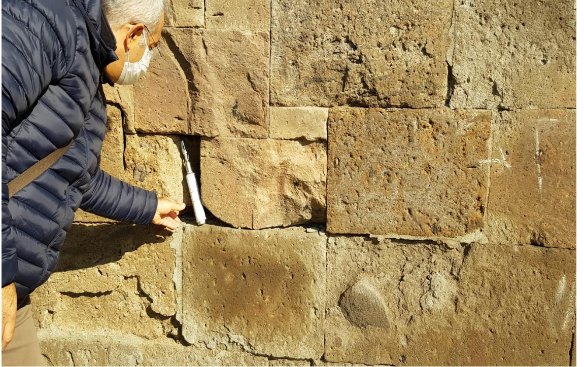
Şekil 5. 3 Çifte Kümbet'te gözlenen fiziksel bozunmadan bir görünüm
