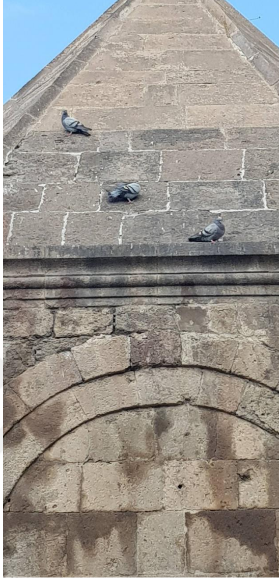
Şekil 6. 10 Hasbek Kumbeti çatısında bulunan kuşların dışkıları, biyolojik bozunma
