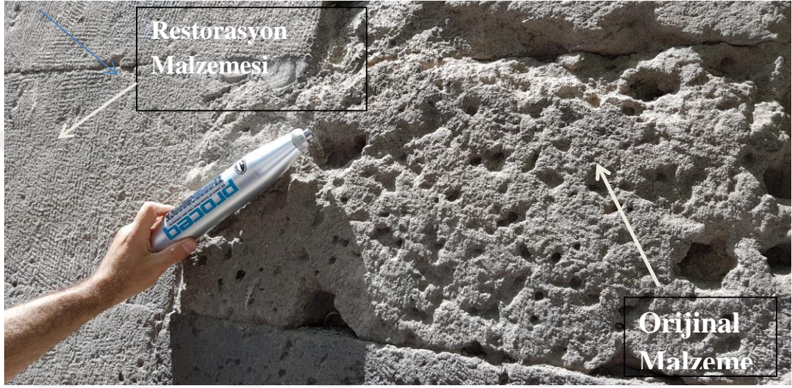
Şekil 6. 6 Selçuklu Emir 2 Kümbeti'nde orta seviyedeki ignimbiritlerde gözlenen petegözlülük
