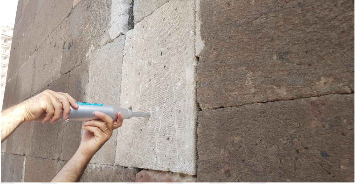
Şekil 3. 3 Bu tez çalışması kapsamında tarihi kümbetlerde gerçekleştirilen Schmidt çekici deneyinden bir görünüm
