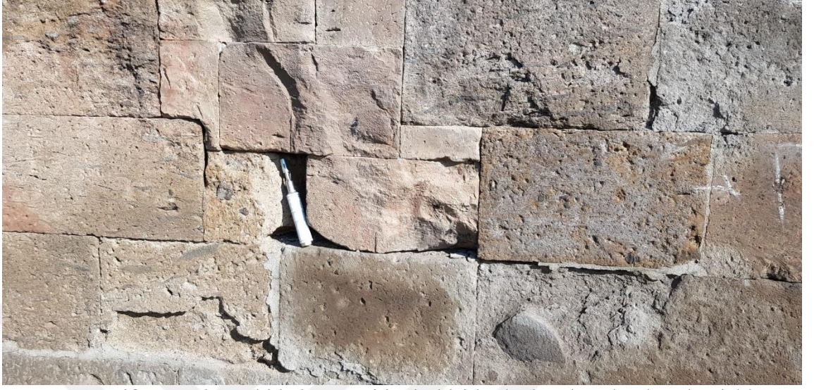
Şekil 6. 18 Çifte Kümbet'teki kahverengi ignimbiritlerde derz boşalmaları, kavlaklanma ve petegözlülük oluşumları
