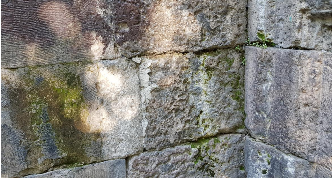
Şekil 5. 19 Ali Cafer Kümbeti'nin bazı bloklarında gözlenen yosunlanma ve çimlenme
