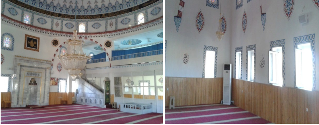
Foto 3.4. Tufanpaşa Camisinin İçinden Görünüm.
