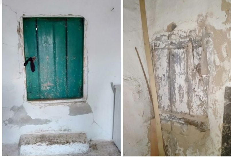
Foto 3.52. Cumhuriyet Mahallesi'ndeki ve Yenice Mahallesi'ndeki Farklı İki Evde Bulunan, Yanlarındaki Ahırlarla Doğrudan Bağlantıyı Sağlayan Küçük Kapılar.
