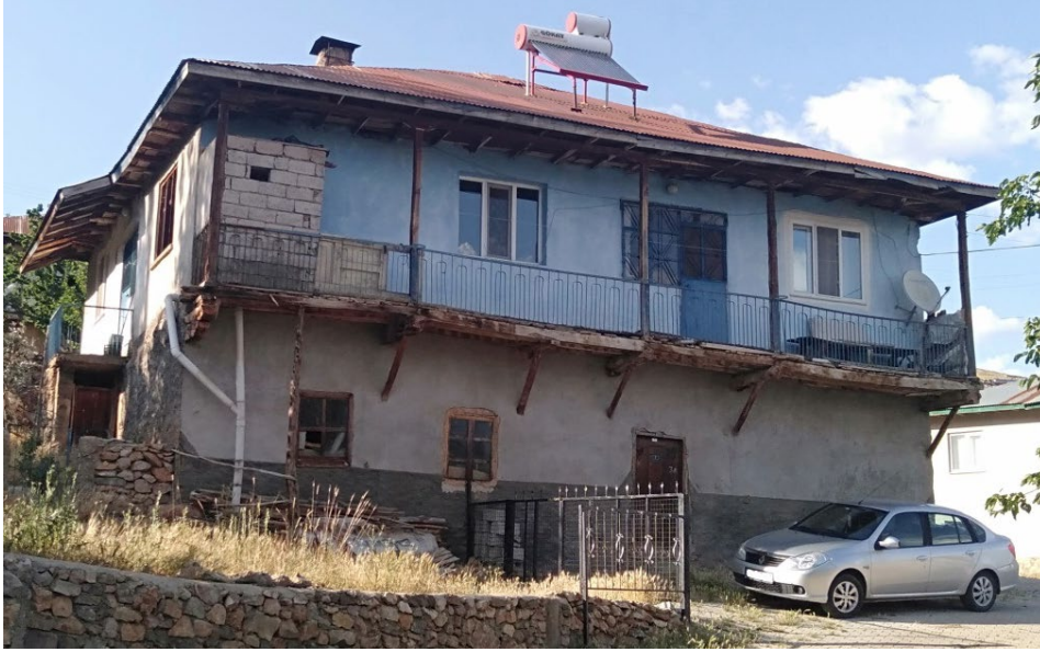
Foto 3.45. Yenice Mahallesiinde Bulunan Eski Bir Evin Güneybatıdan Görünümü.
