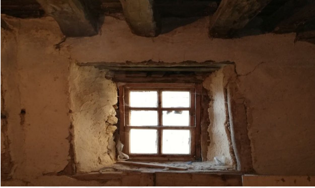
Foto 3.42. Dođanbeyli Kırsal Mahaltesinde Bulunan Eski Bir Evin Samanlı Çamurla Sıvanmıř Duvarı.
