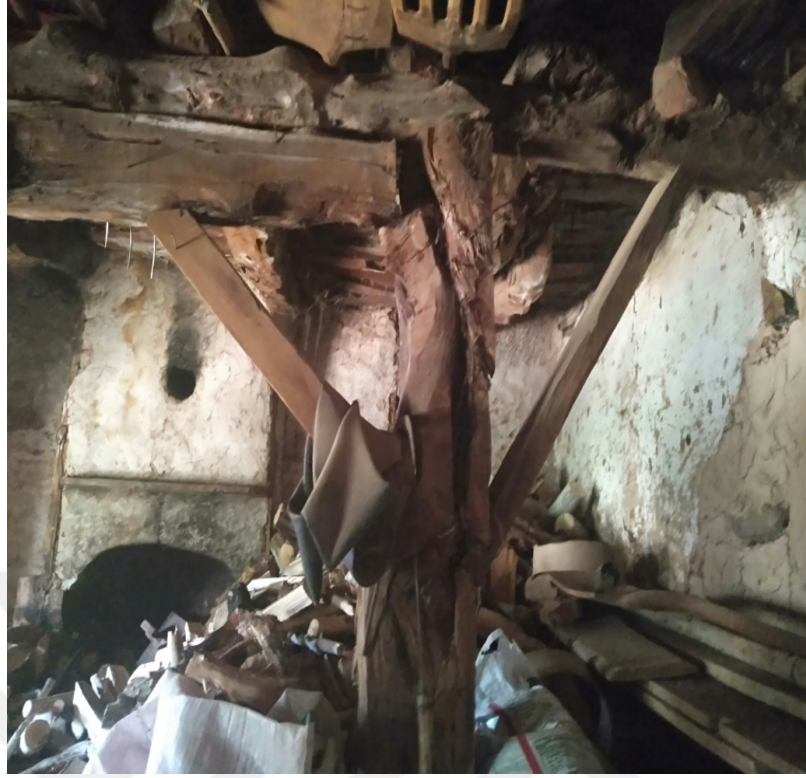
Foto 3.46. Yenice Mahallesi'nde Bulunan Geleneksel Bir Mesken'deki Evliğin Ortasındaki Direk ve Karşı Duvarda Ocak Bölümü.
