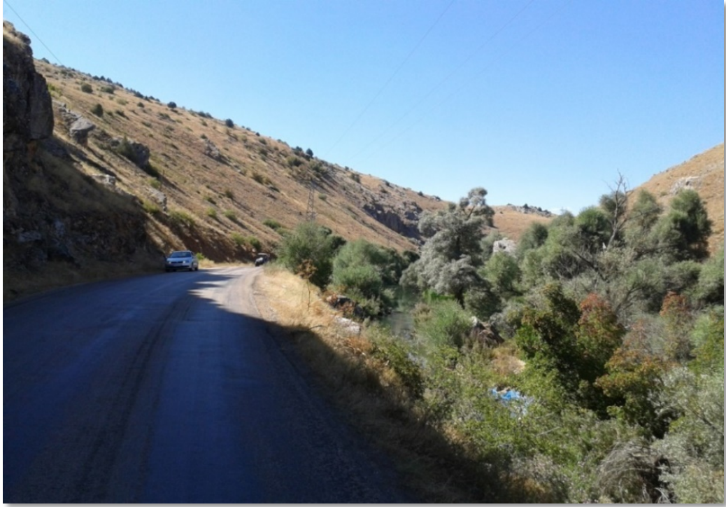
Foto 1.4. Saray Boğazı'nın Güney Kesiminden Bir Görünüm.
