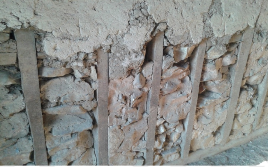
Foto 3.36. Doğanbeyli Kırsal Mahaltesinde Bulunan Eski Bir Evin Alt Katının İç Duvarının Yapısı.
