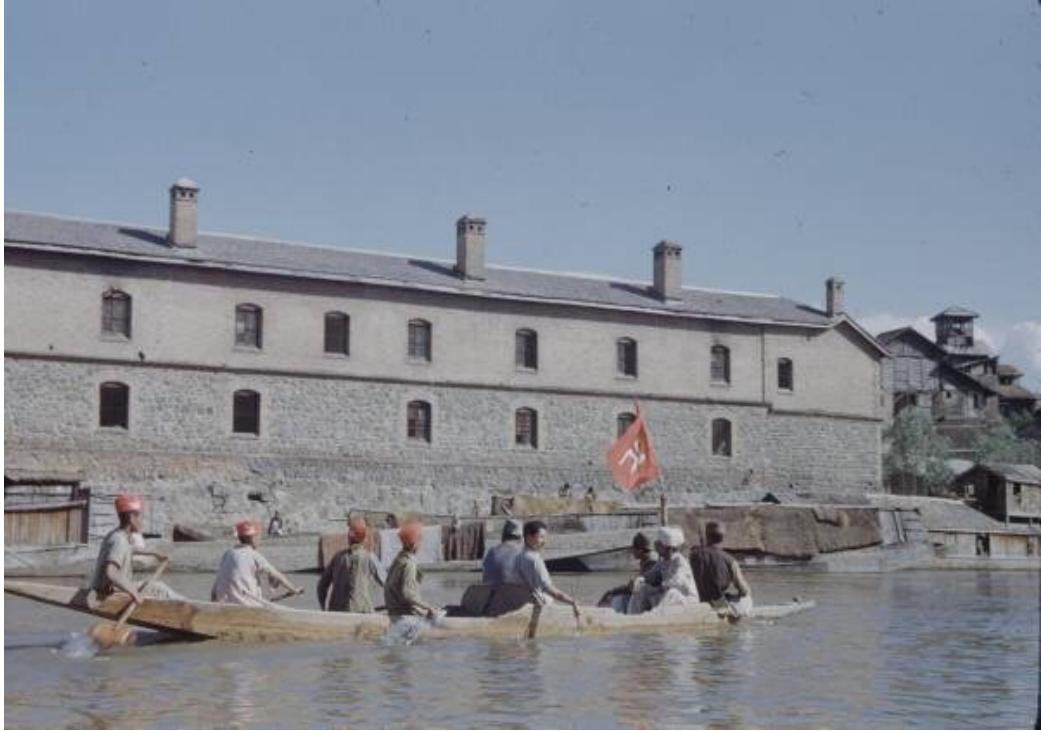
Kazak göçmenlerin kaldığı bina
