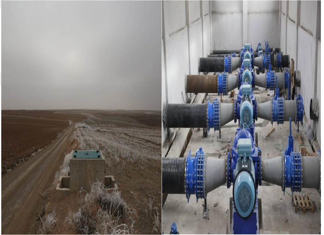
Resim 3.1.Yamula Barajı Sulama ve Pompaj Çalışması
