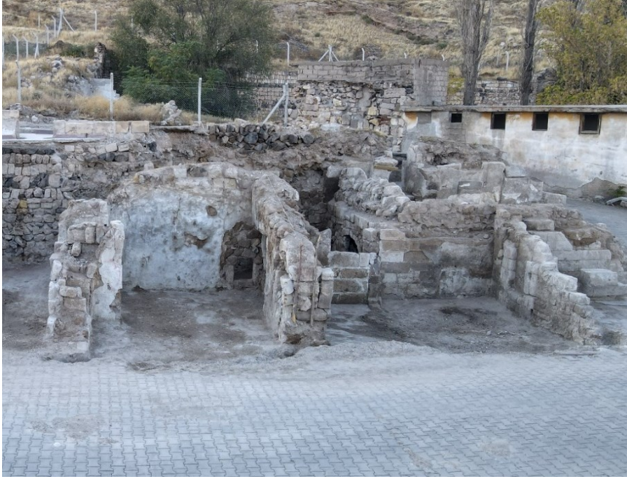
Fotoğraf 4. Tahtalı Kahvehane'nin zemin kat duvarları.
