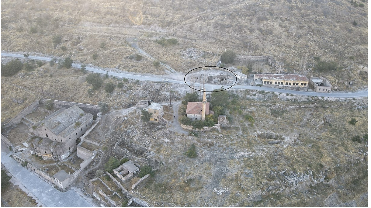
Fotoğraf 2. Meryem Ana Kilisesi, kuzeyinde Eski Cami ve karşısında yıkılmış durumda kahvehane.
