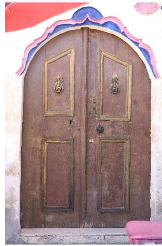
Şekil 3.56. Mustafapaşa Kapı Örneği 6
