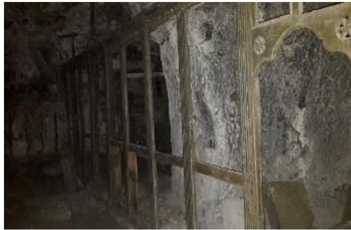
Őekil 3.250. Aya Maryeros Manastırı (Nevőehir Mőzesi'nin arřivinden)
