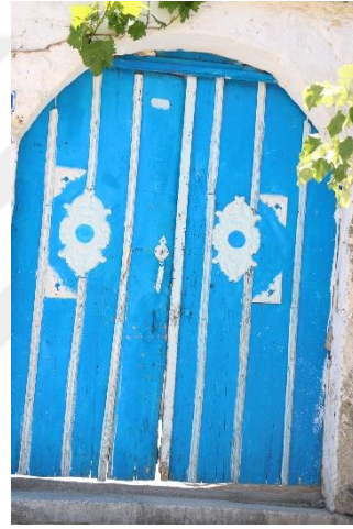
Şekil 3.54. Mustafapaşa Kapı Örneği 4
