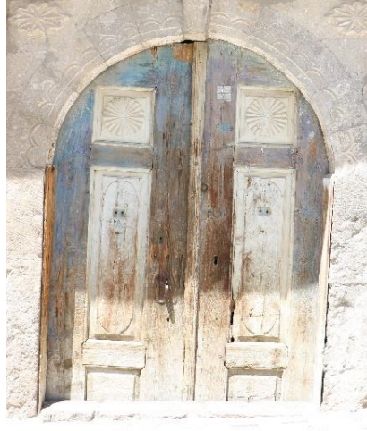
Şekil 3.57. Mustafapaşa Kapı Örneği 7
