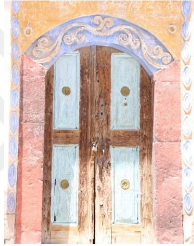
Şekil 3.53. Mustafapaşa Kapı Örneği 3
