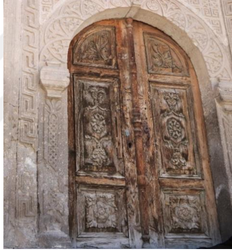
Şekil 3.50. Mehmet Şakir Paşa Medresesi Giriş Kapısı
