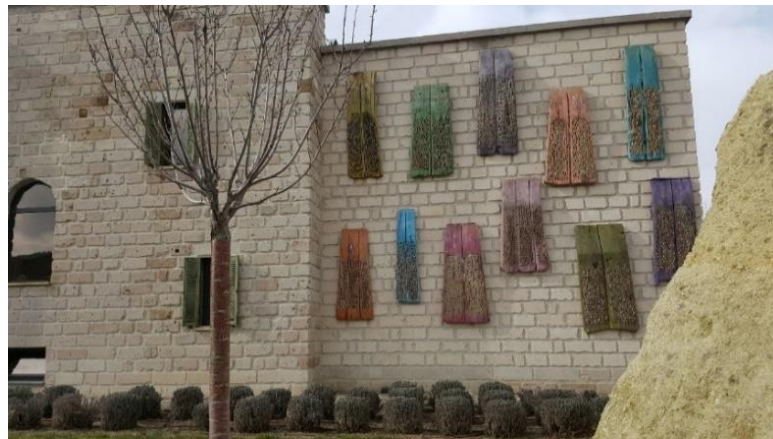
Şekil 3.84. Ajwa Hotels otel binası cephe duvarı
