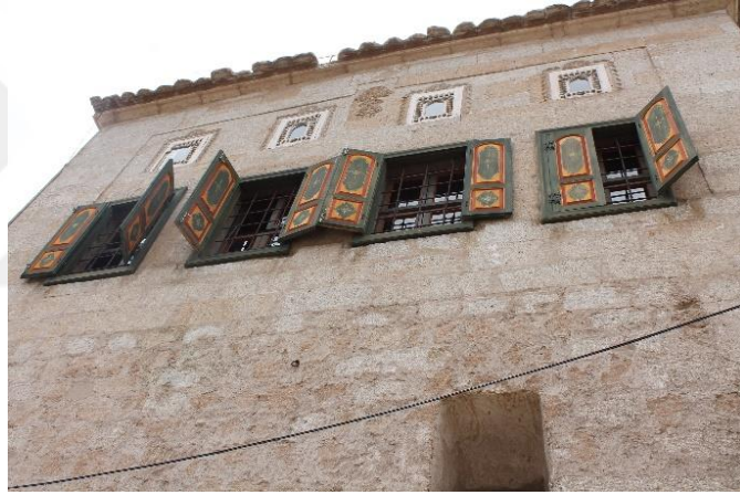
Şekil 3.186. Konak Coffee ve Lounge Bina Dış Görünümü
