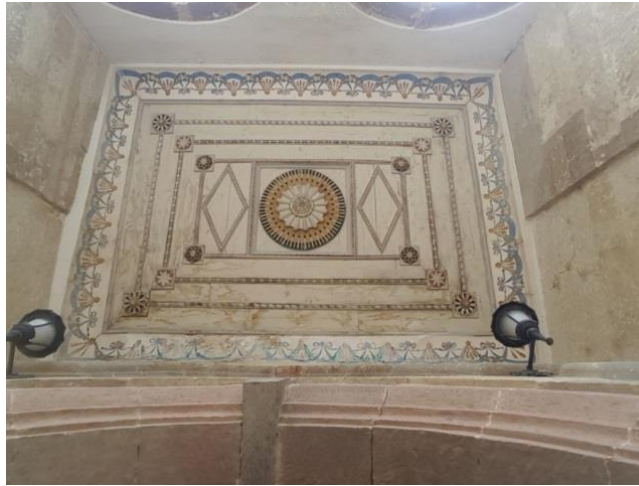
Şekil 3.71. Haralambos Sultanidis Konağı Girişi Balkon Kısmı Tavanı
