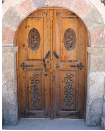
Şekil 3.51. Mustafapaşa Kapı Örneği 1
