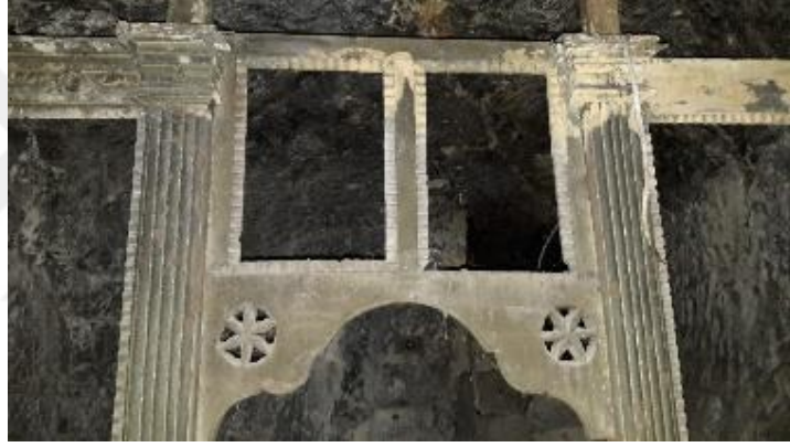
Őekil 3.249. Aya Maryeros Manastırı (Nevőehir Mőzesi'nin arřivinden)
