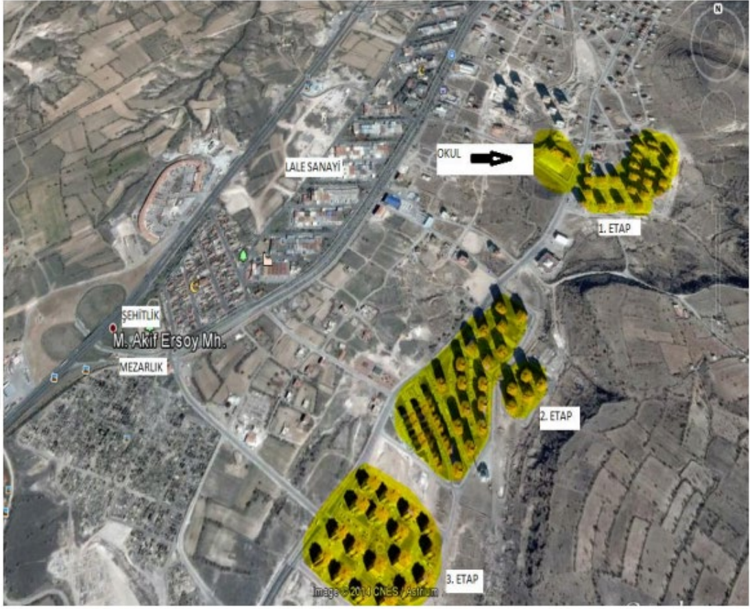
Şekil 7 Kentsel Dönüşüm Sonrası Mehmet Akif Mahallesi'nde Yapılan TOKİ Konutları
