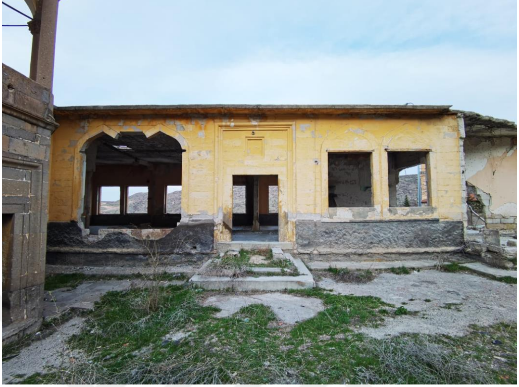
Fotoğraf 158. Ek yapının giriş cephesi
