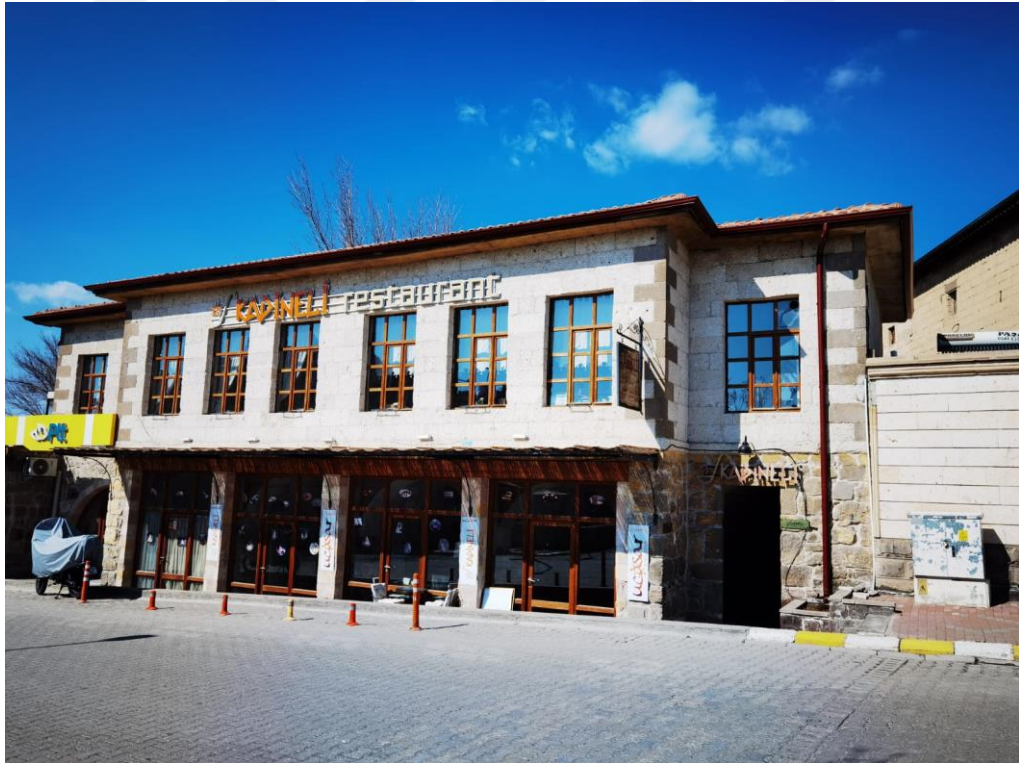
Fotoğraf 114. Güney cephede yer alan dükkânlar
