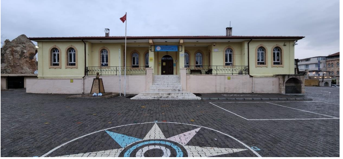
Fotoğraf 84. Ortahisar İlköğretim Okulu güney cephe görünümü
