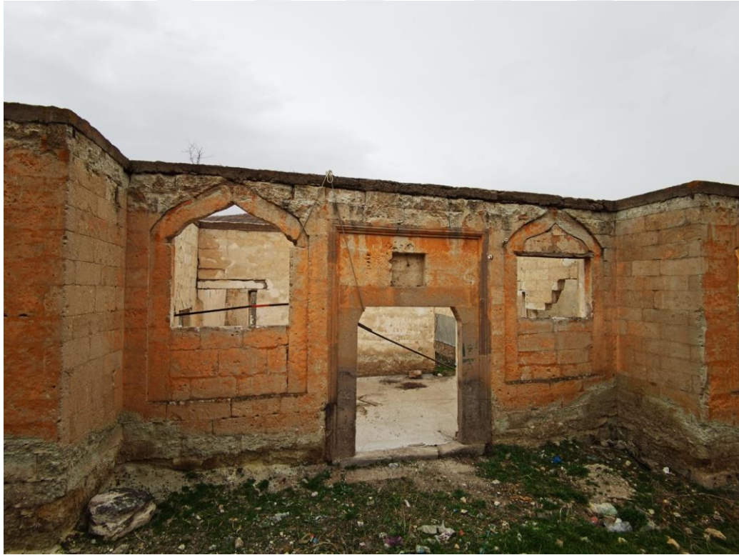
Fotoğraf 129. Göre İlköğretim Okulu batı cephe giriş kapısı
