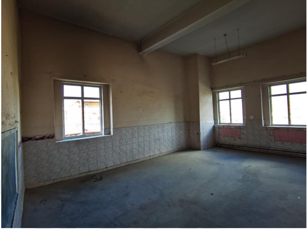
Fotoğraf 190. Kuzeydođu cepheadeki derslik
