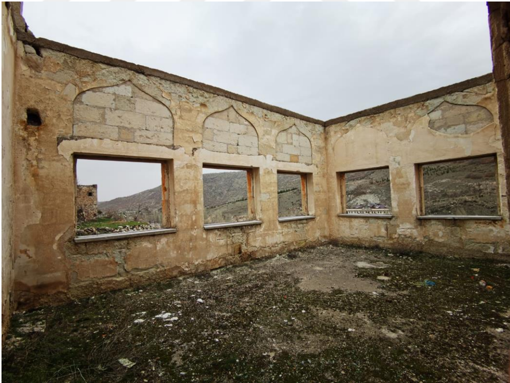
Fotoğraf 143. Birinci kat kuzeydoğuda yer alan derslik
