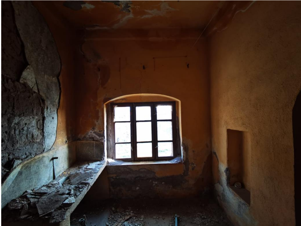
Fotoğraf 258. Güneydeki mutfak mekânı
