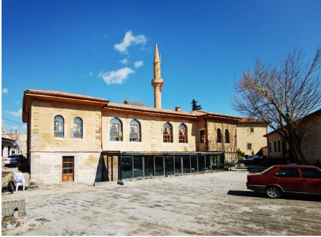
Fotoğraf 109. Batı cephedeki bodrum kata giriş kapı
