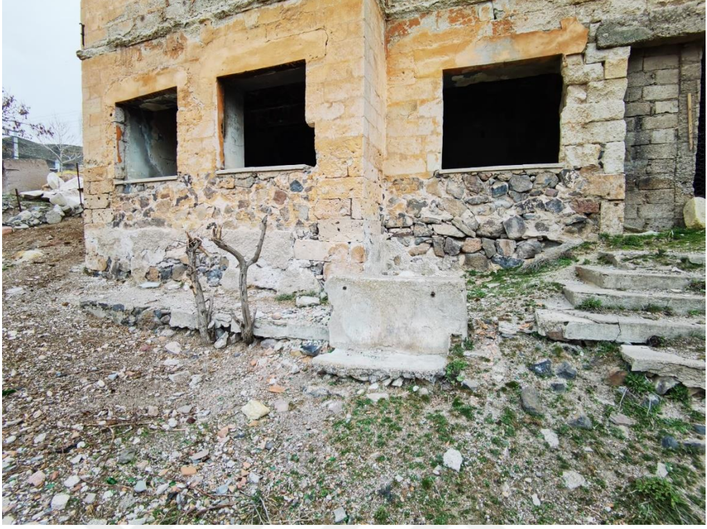
Fotoğraf 150. Zemin katta giriş merdivenlerinin gneyindeki eme
