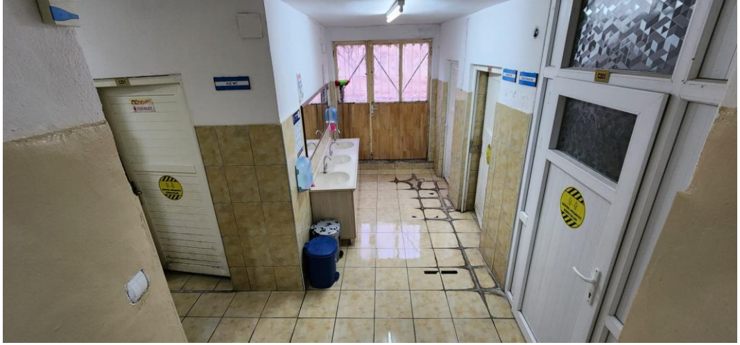
Fotoğraf 72. Kuzey cepheye eklenen tuvalet ve depo mekânı
