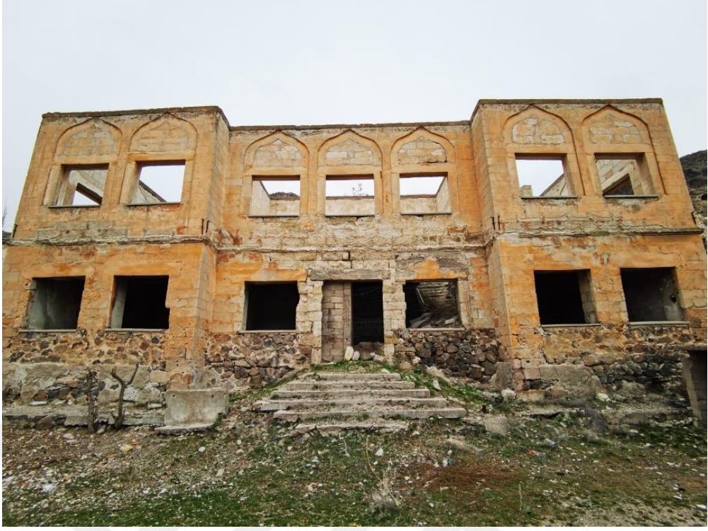
Fotoğraf 126. Göre İlköğretim Okulu doğu cepheden görünüşü
