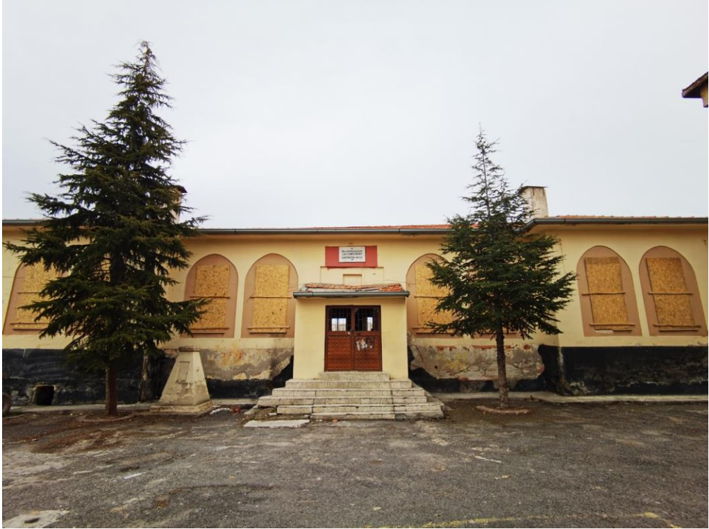
Fotoğraf 185. Çat Cumhuriyet İlköğretim Okulu batı cephe görünüşü
