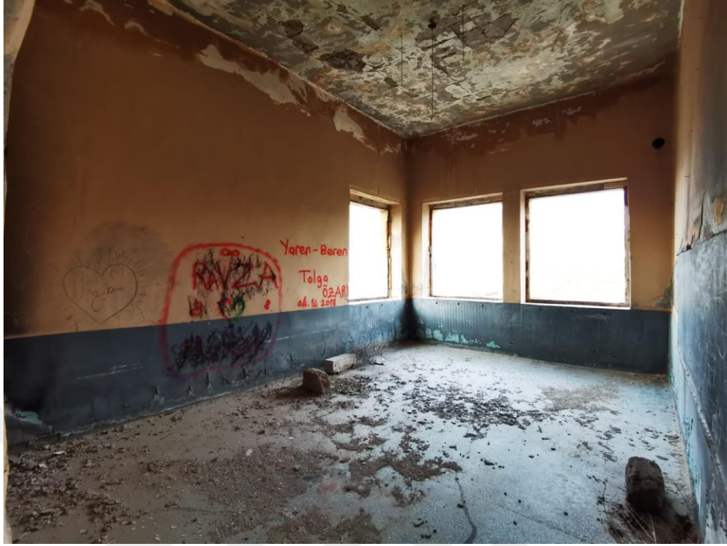
Fotoğraf 160. Kuzeydođu cephedeki derslik
