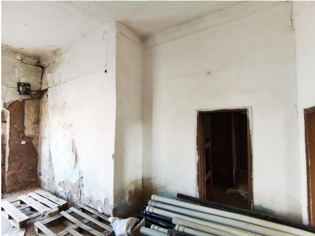
Fotoğraf 251. Güney derslikten batı cepheye geçiş
