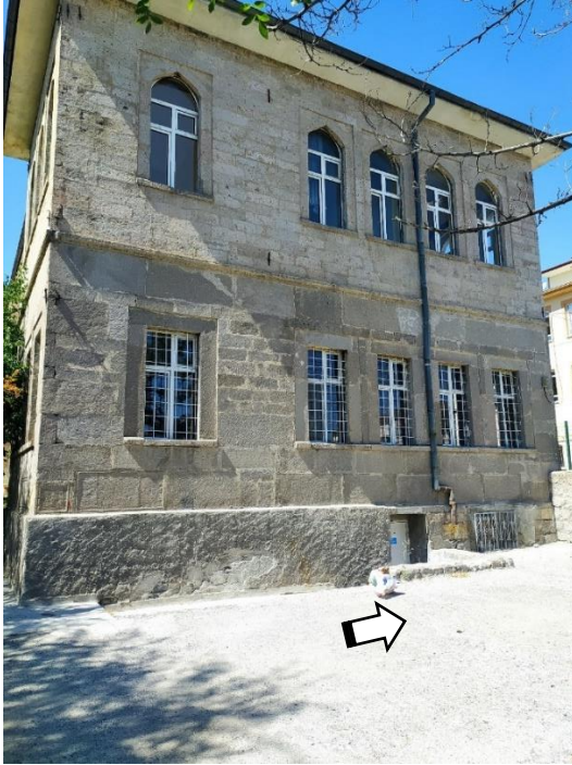
Fotoğraf 18. Doğu cephesi bodrum kata giriş
