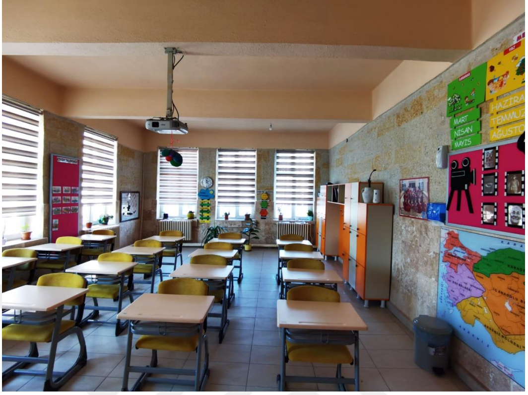
Fotoğraf 208. Kuzeybatı cephede yer alan derslik
