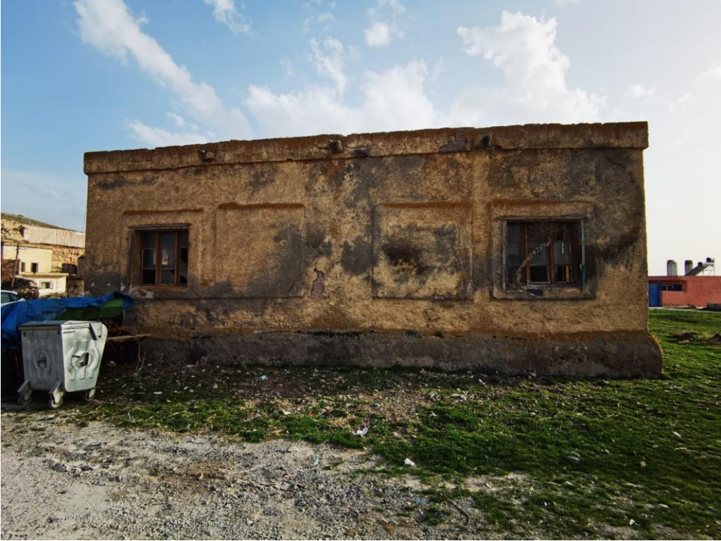
Fotoğraf 249. Doğu cephede kapatılan pencereler
