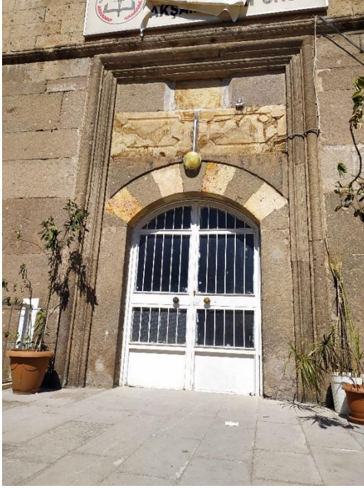
Fotoğraf 22. Güney cephe giriş kapısı
