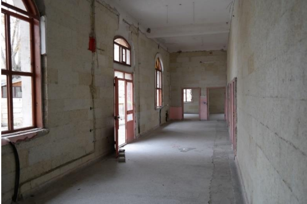
Fotoğraf 102. Restorasyon öncesi koridor mekânı (Argos Yapı Arşivinden)
