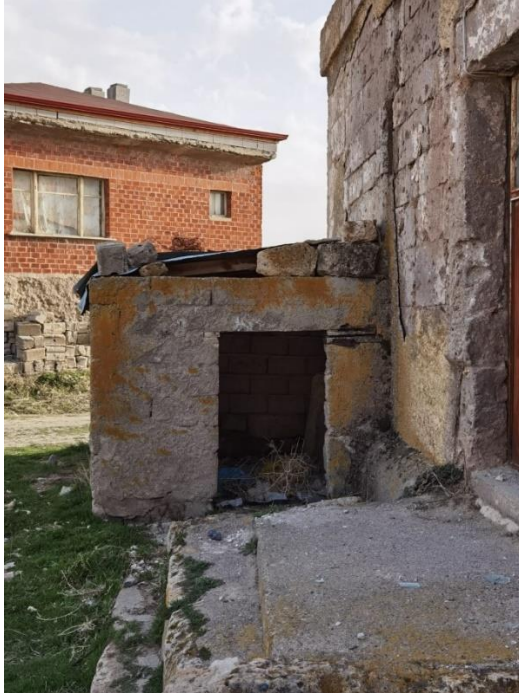
Fotoğraf 260. Güney cephede bulunan depo alanı
