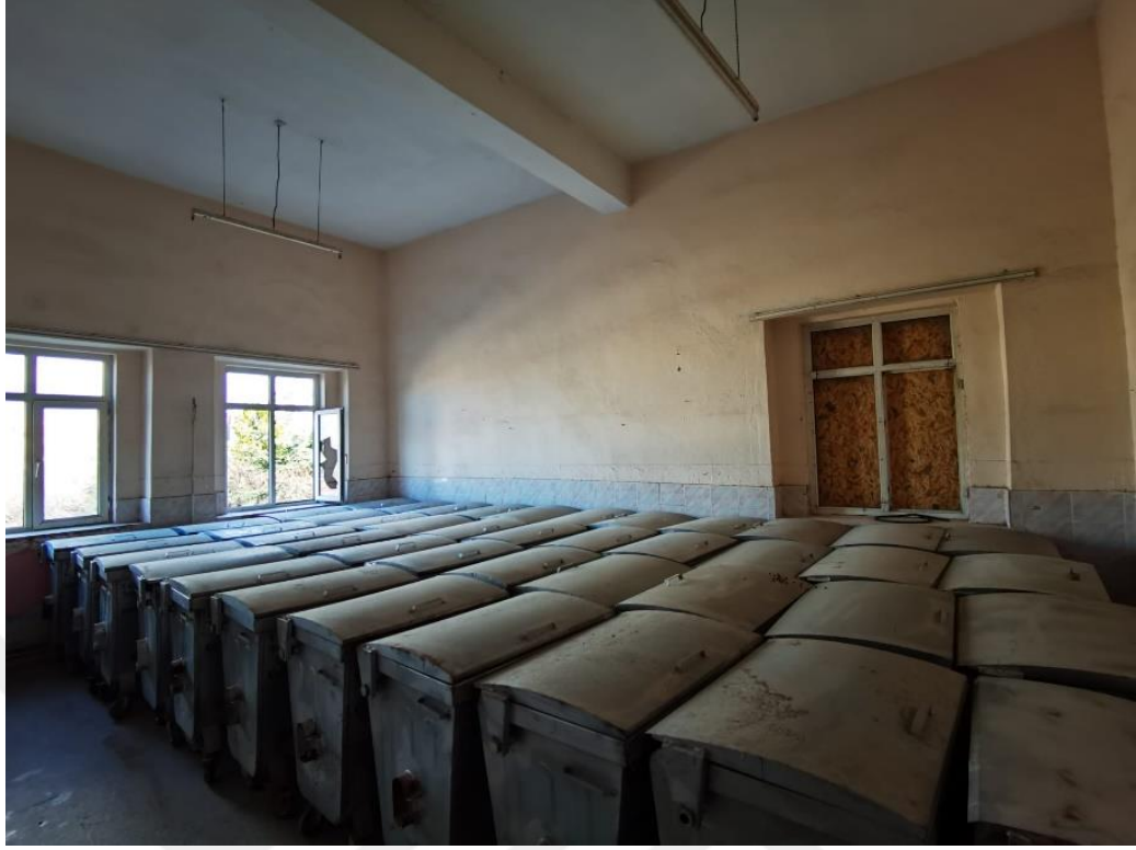
Fotoğraf 192. Güneydoğu cephedeki derslik
