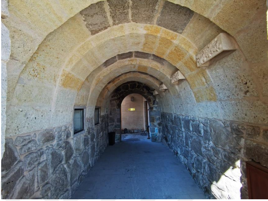
Fotoğraf 123. Sokak cephesinde bulunan tonozlu giriş
