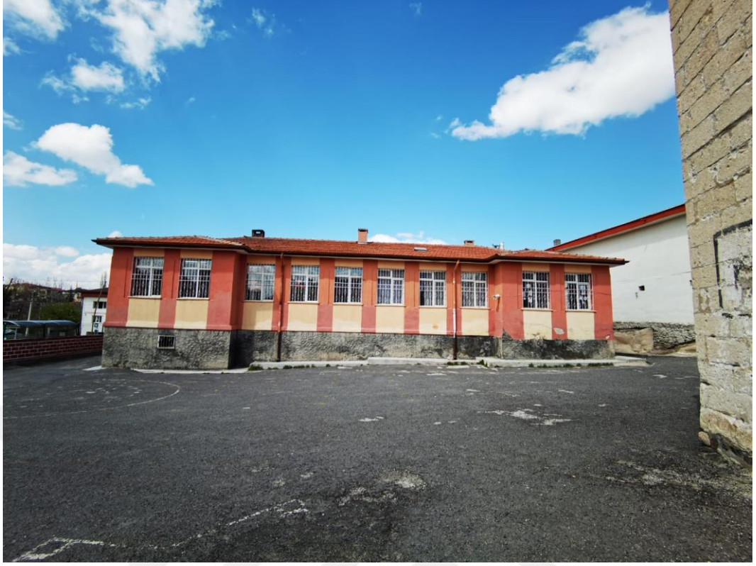
Fotoğraf 239. Sulusaray İlköğretim Okulu güney cephe görünüşü
