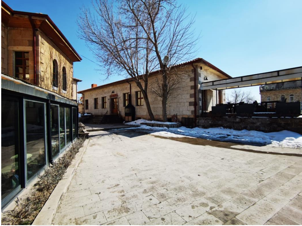
Fotoğraf 115. İkinci binanın avludan görünüşü
