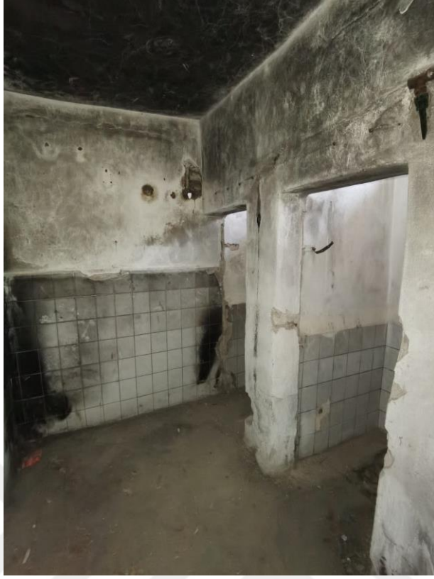
Fotoğraf 178. İki kabinli tuvalet mekânı
