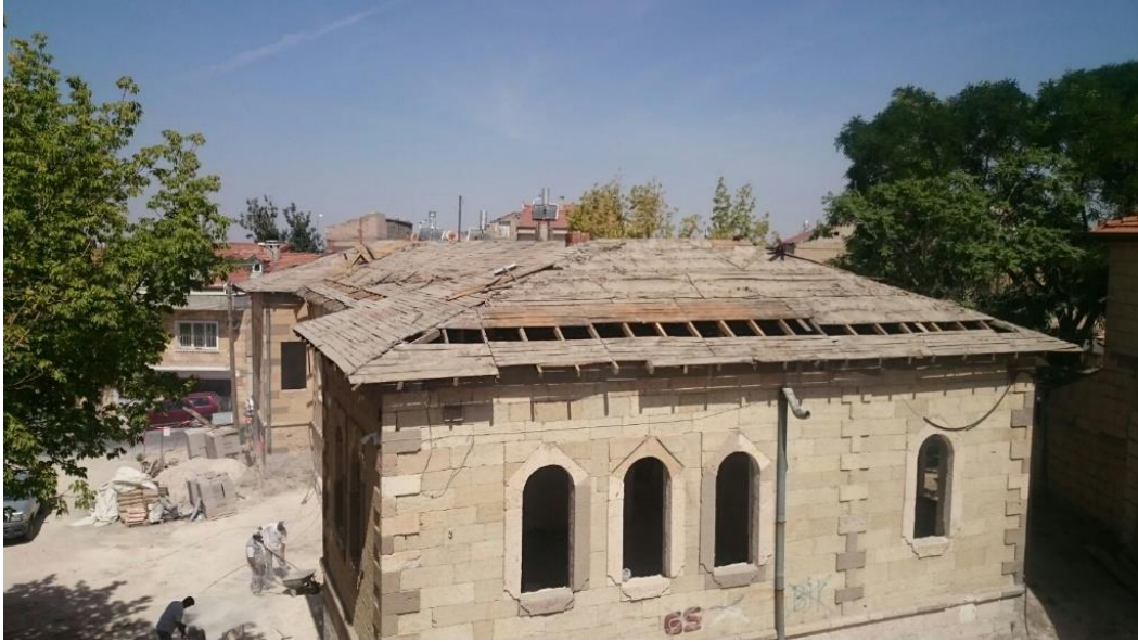
Fotoğraf 110. Uçhisar İlköğretim Okulu üst örtüsü (Argos Yapı Arşivinden)
