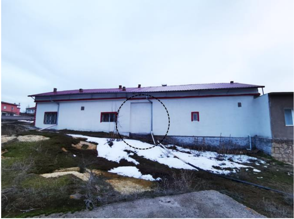
Fotoğraf 241. Çardak İlkokulu kuzey cephe görünümü
