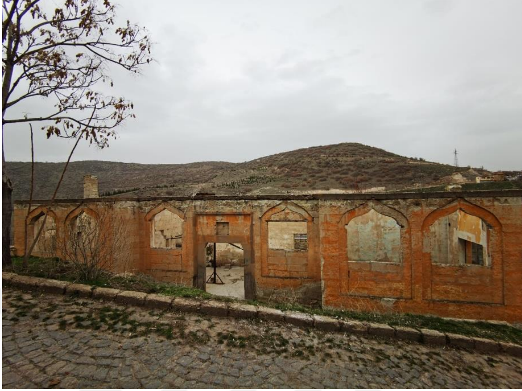
Fotoğraf 128. Göre İlköğretim Okulu batı cepheden görünüşü
