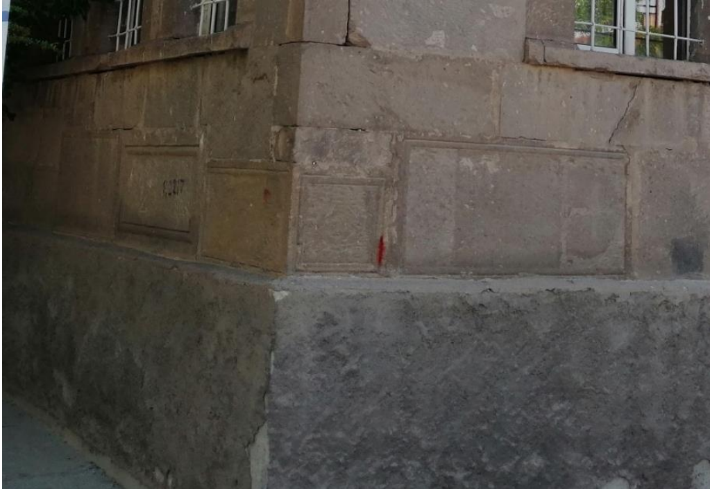
Fotoğraf 61. Güney cephe ve doğu cephenin kesiştiği noktadaki devşirme malzemeler
