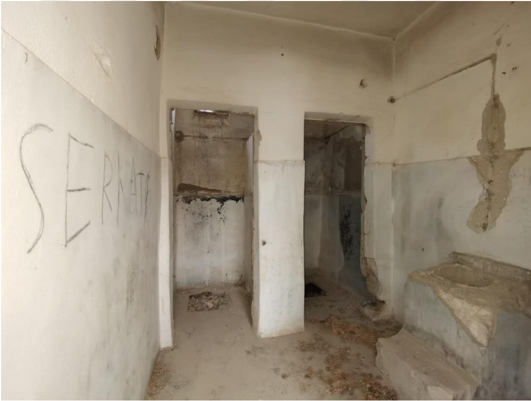
Fotoğraf 181. İki kabinli tuvalet mekânı
