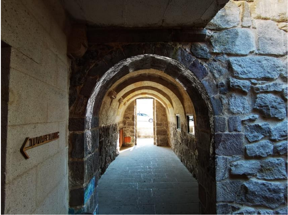
Fotoğraf 124. Tonozlu mekânın bitimindeki tuvalet bölümü
