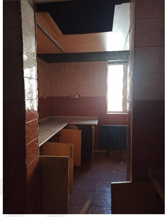
Fotoğraf 38. Mutfak mekânı kuzey cephe görünüşü
