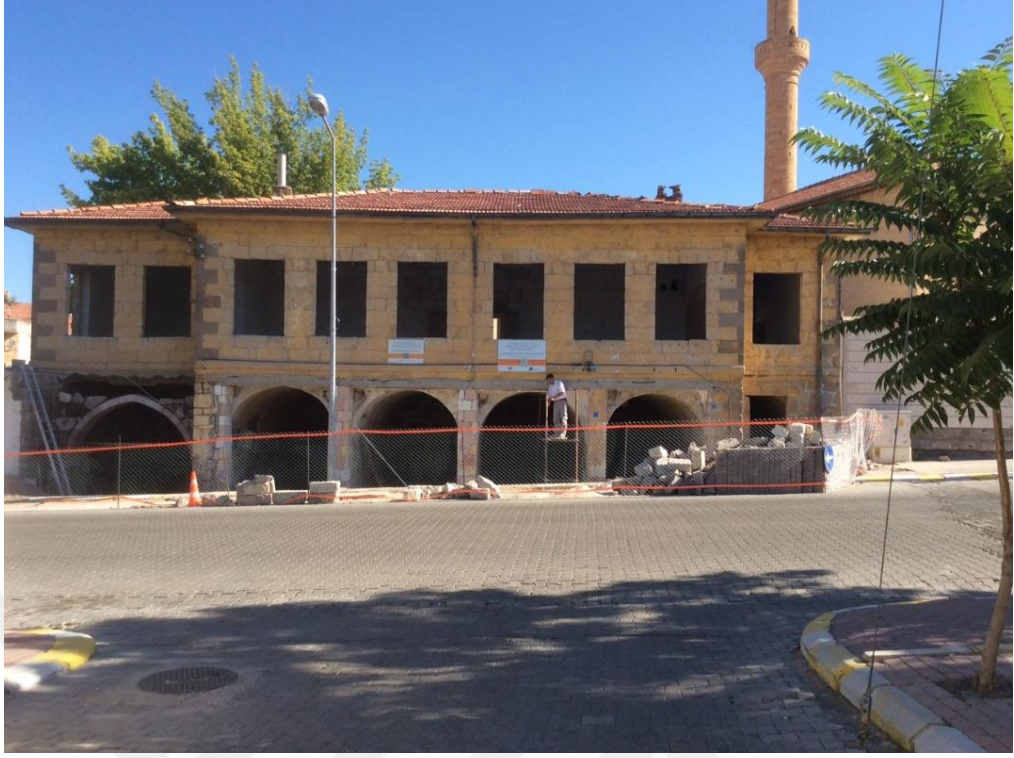
Fotoğraf 113. İkinci binanın sokak cephesinden görünüşü
