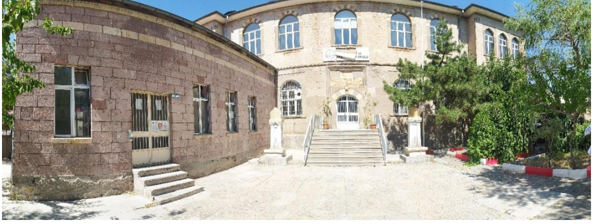
Fotoğraf 14. Yapının güneybatı cephesine bitişik inşa edilen müştemilat
