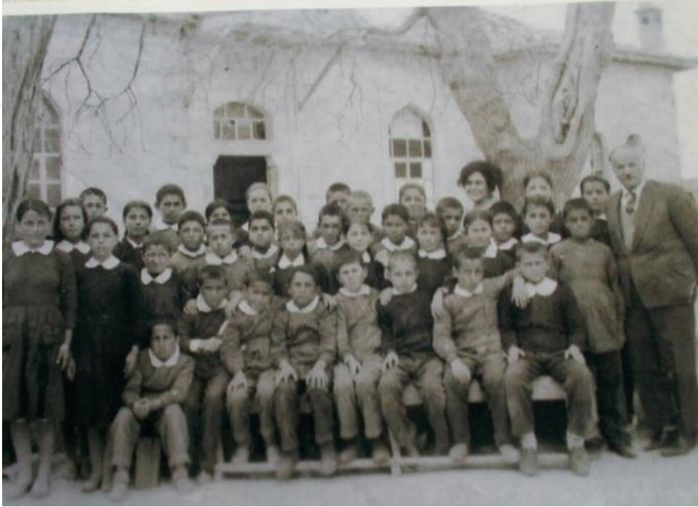
Fotoğraf 88. Uçhisar Fatih İlköğretim Okulu (1960'lı yıllar) (Argos Yapı Arşivinden)
