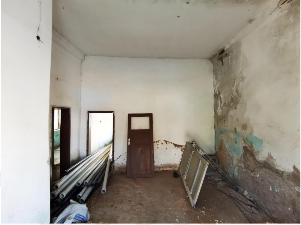
Fotoğraf 248. Güney cephedeki derslik
