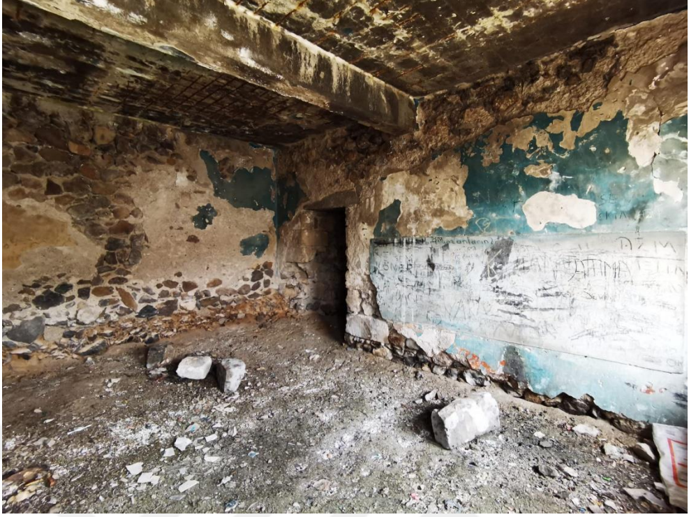
Fotoğraf 134. Zemin kat güney cephedeki derslik
