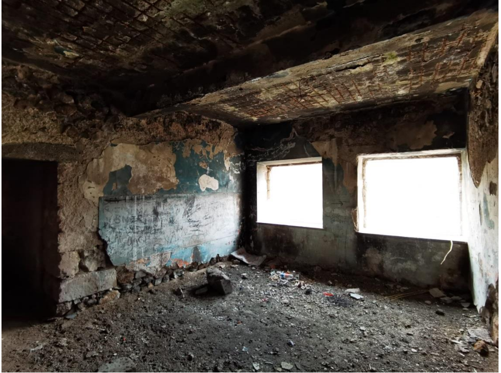
Fotoğraf 133. Zemin kat güney cephedeki derslik
