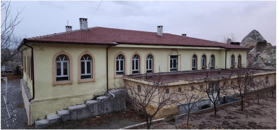
Fotoğraf 86. Ortahisar İlköğretim Okulu kuzeydoğu köşede yer alan merdiven
