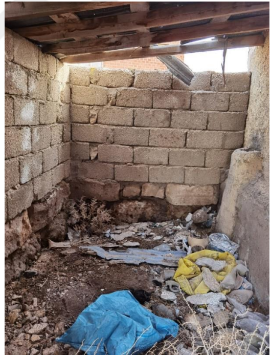
Fotoğraf 261. Güney cephedeki depo alanı
