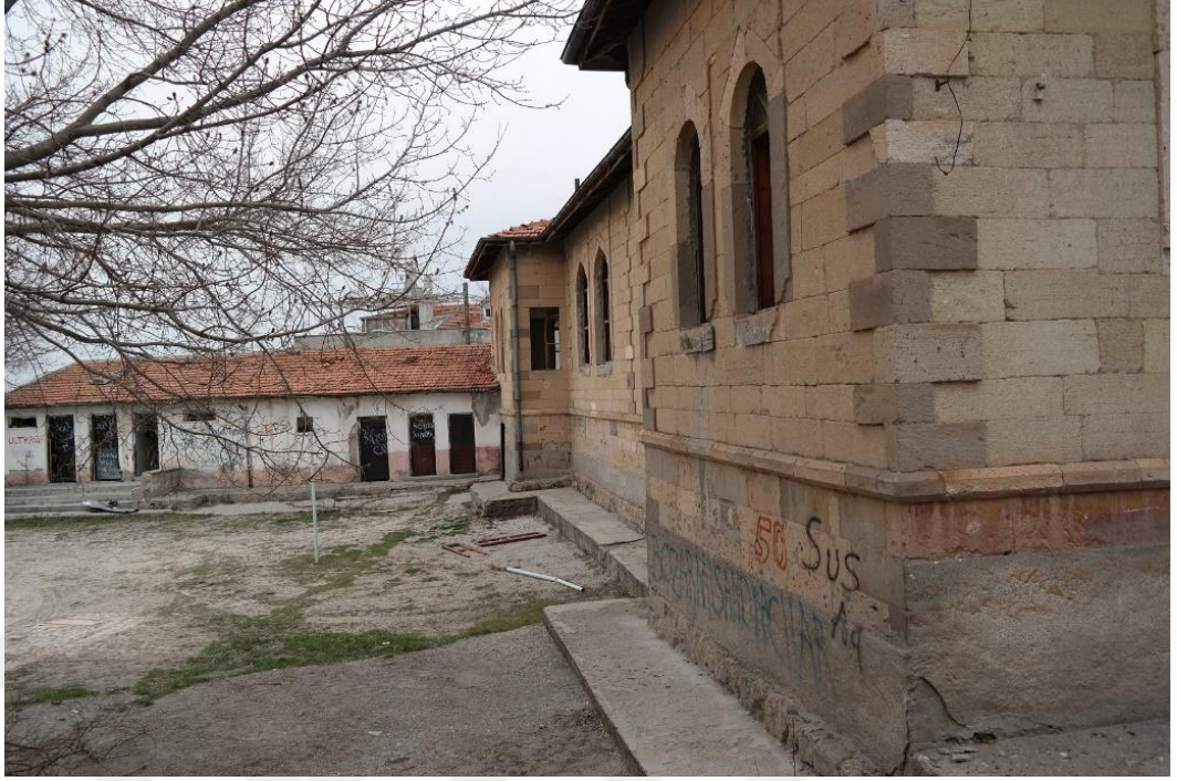
Fotoğraf 111. Batı cepheye bitişik tuvalet mekânı (Argos Yapı Arşivinden)
