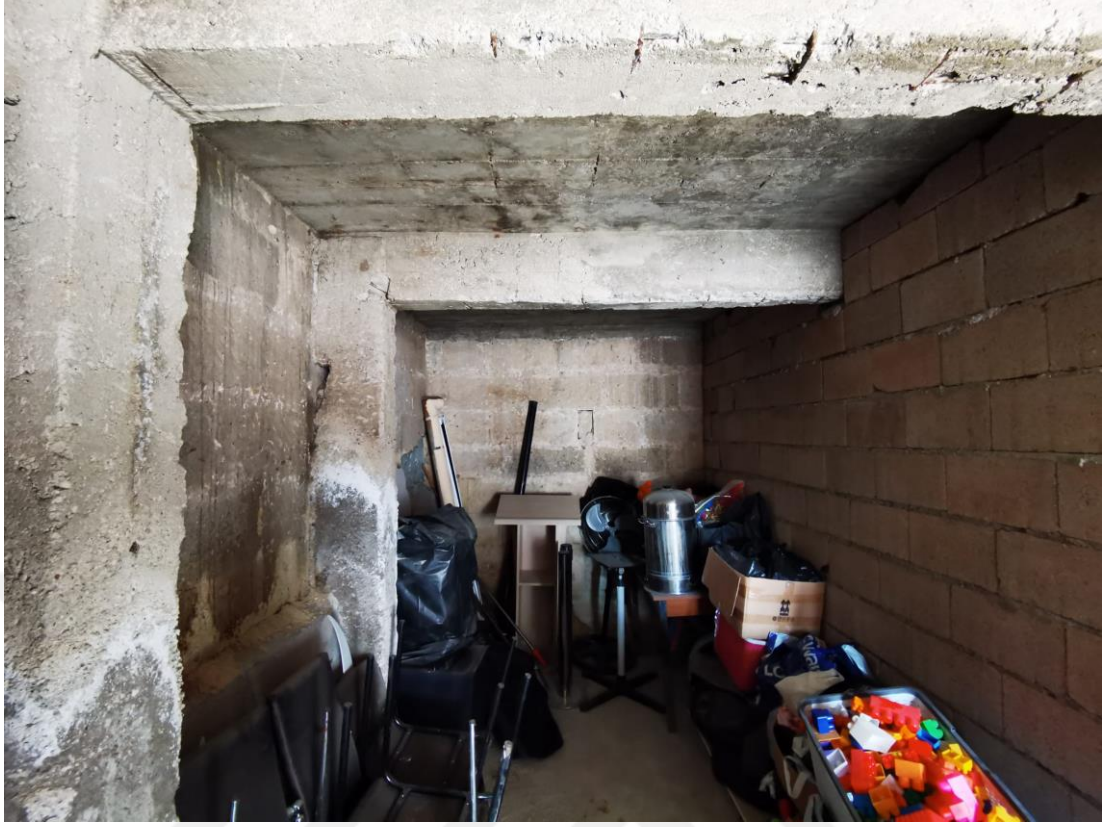
Fotoğraf 220. Bodrum kat depo alanı
