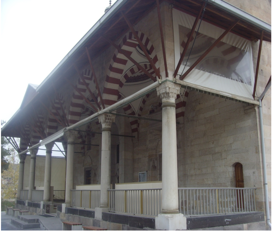
“Fotoğraf 40:”Nevşehir, Kurşunlu Camii - Revaka Kuzeybatıdan Bakış.
