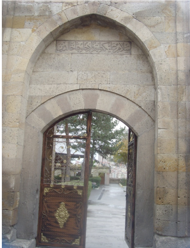
“Fotoğraf 37:” Nevşehir Kurşunlu Camii - Batı Kapısı
