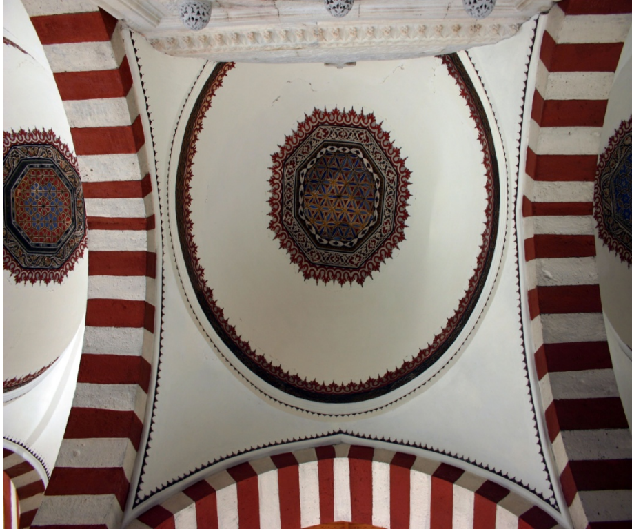
“Fotoğraf 43:” Nevşehir, Kurşunlu Camii - Son Cemaat Yeri Kubbe Süslemeleri
