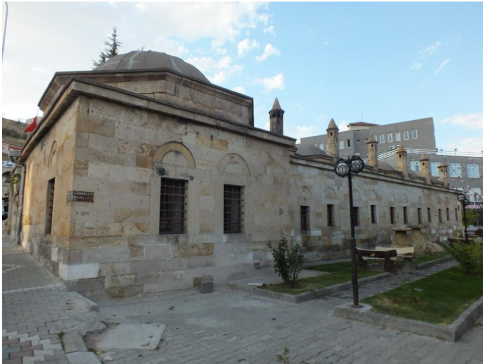
Gülşehir Karavezir Kütüphanesi'nin (Medresenin) arkadan görünüşü
